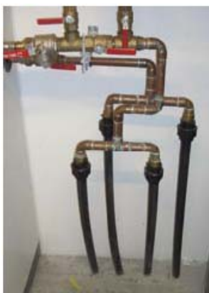
Fig A3.4 Plastrør forsvinner ned i bakken (fjellet)
