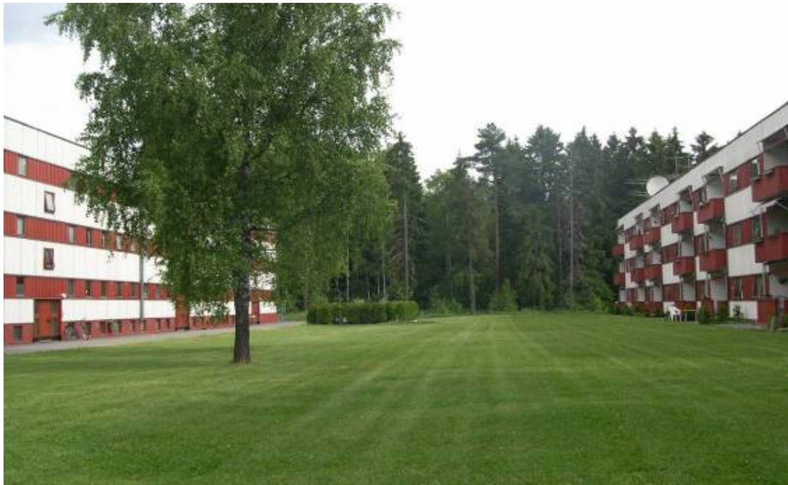
Fig. A5.4 Øst- og vestfasade før rehabilitering. Foto: Arkitektskap AS, 2009.
