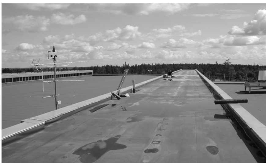
Figur 3.1 Oversiktsbilde av tak 5 i undersøkelsen. Foto: Byggforsk
