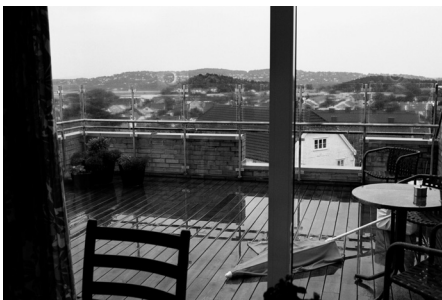
Terrasse foran stuevinduet gir redusert sikt spesielt i sittende stilling. Mindre tydelig på bildet er at terrasser for etasjen over reduserer dagslyset. Valhalla
