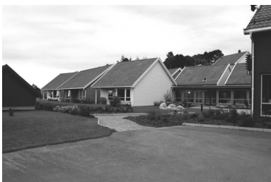
14 selvstendige boliger, fellesareal, stue og kjøkken og uteplass. Base for hjemmetjenesten i huset og tilbud om felles måltider. (Søgne)
