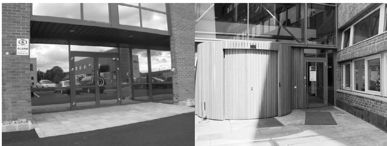
Inngang med terrenget ute i plan med gulvet inne er den foretrukne løsningen i eksempelprosjektene. Resultatet er at ramper og trapper er unødvendige, og tilgjengeligheten blir enkelt og naturlig løst.
