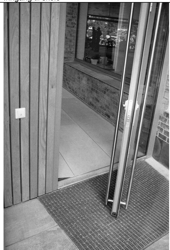
Inngang til publikums- og kontorbygg. Merk spesielt terskelløsningen og plasseringen av døråpnerknapp
