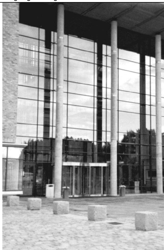
Inngang til kontorbygg. Enstonig grått. Nærmest utilgjengelig for synshemmede (se teksten).
