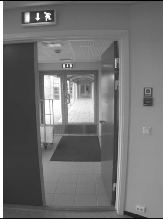
Skole. Romslig vindfang og lave terskler gir bra tilgjengelighet for bevegelseshemmede
