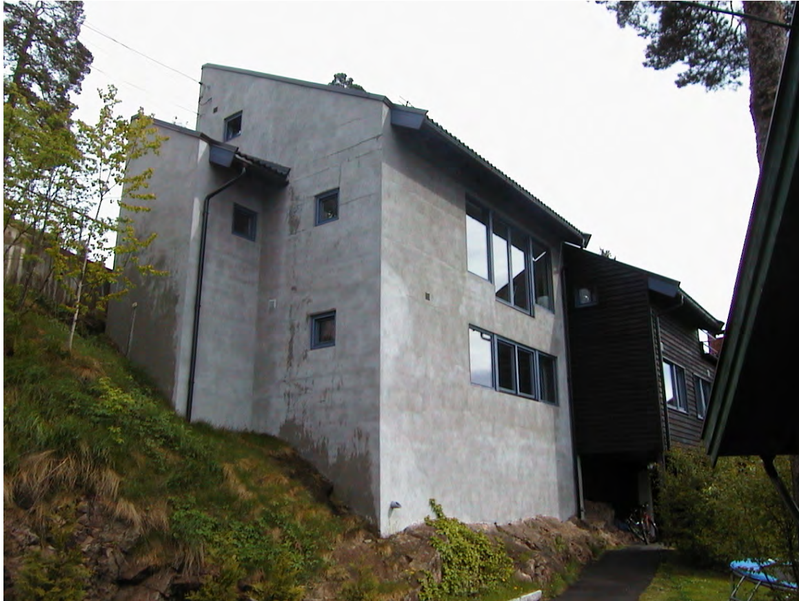
Foto 1 Tilbygd del av Bygning 1 (Foto: Geir Wold Hansen)
