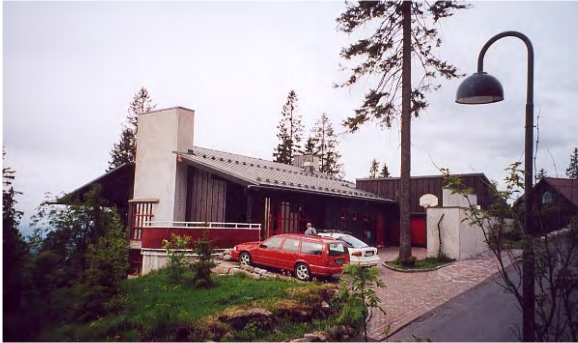
Foto 1 Bygning 2 (Foto: Tore Kvande)
