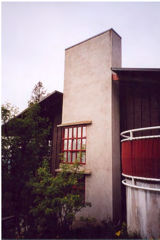
Foto 4 Gavlparti med feste av taksperre (Foto: Tore Kvande)
