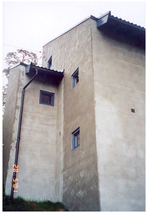
Foto 6 Fasade mot nord og mot vest (Foto: Alf M. Waldum)
