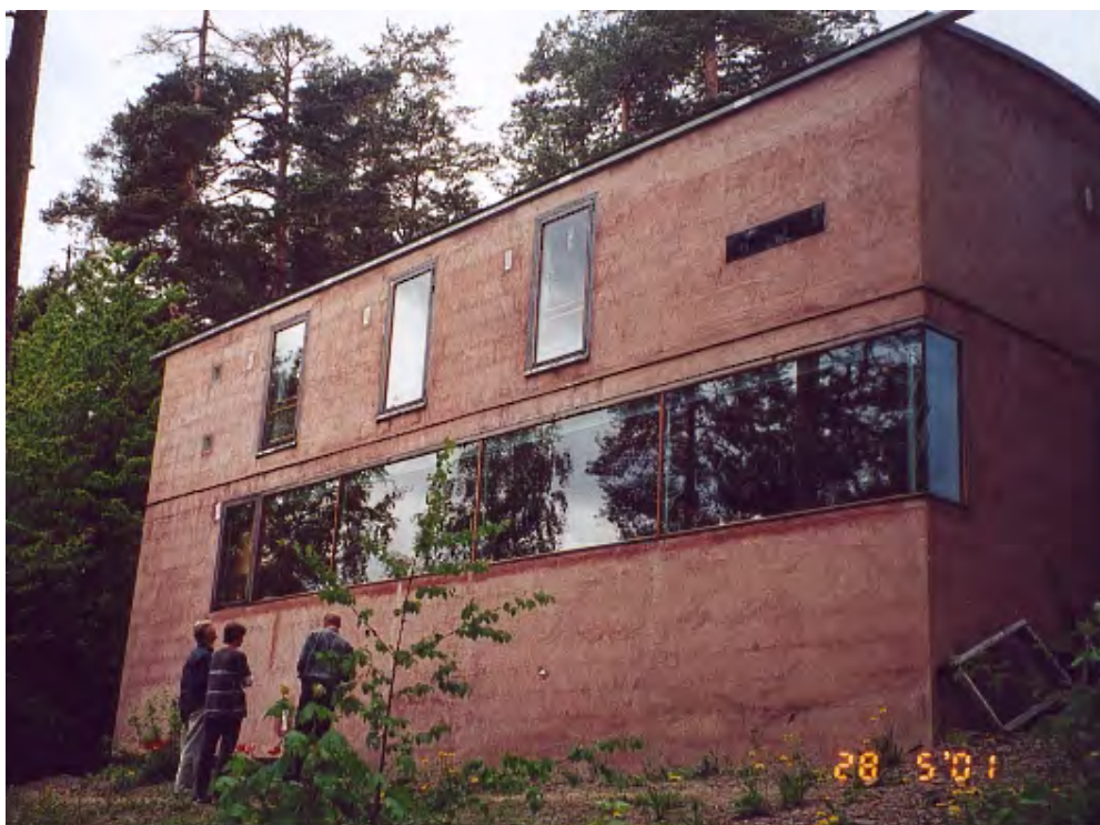
Figur 2.3 Bygning 3. Fasade mot søraust (Foto: Alf M. Waldum)
