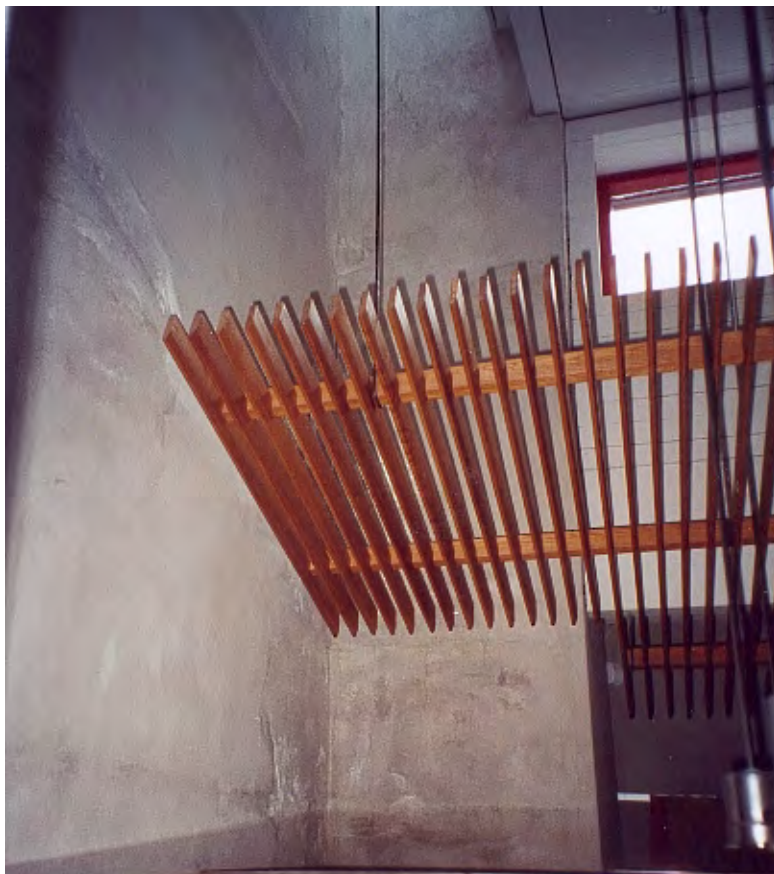
Foto 2 Fuktinntrenging gjennom yttervegg på soverom (Foto: Tore Kvande)
