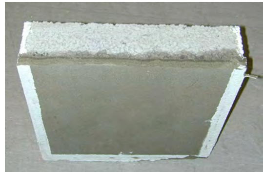
Delt prøve ved mørtelfuge
