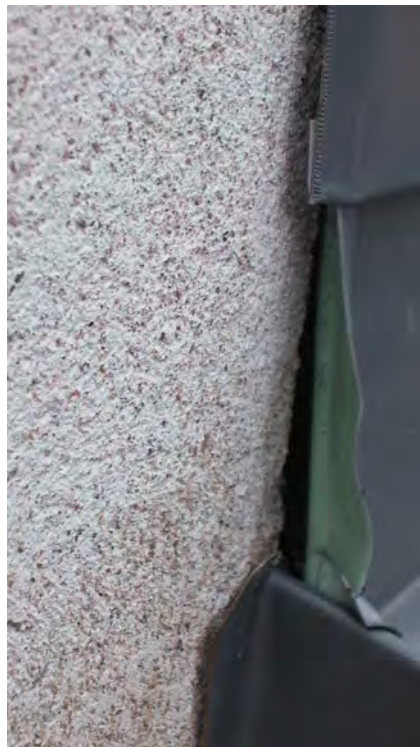
Foto 8 Kort overlapp av takbeslag og murverk (Foto: Geir Wold Hansen)
