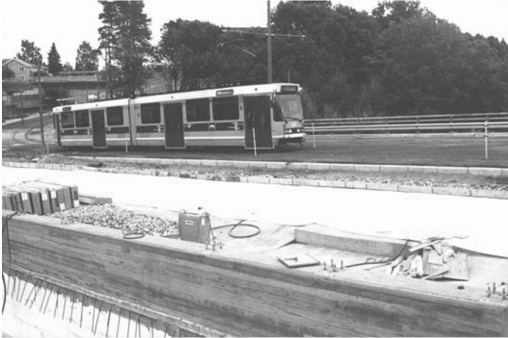
Figur 4. Trikk- og vegtrase over Gaustadbekkdalen i Oslo der resirkulert tilslag er brukt i overbygningen (veg, trikk og gang- /sykkelveg).
