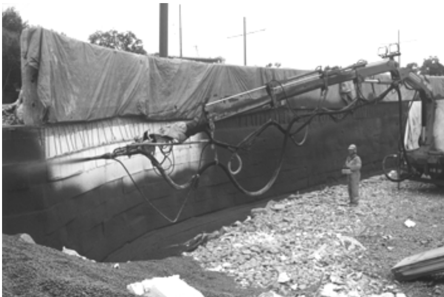
Figur 10. Utsprøyting av sprøytebetong med resirkulert tilslag på EPS-fylling for Gaustadtrikken.
