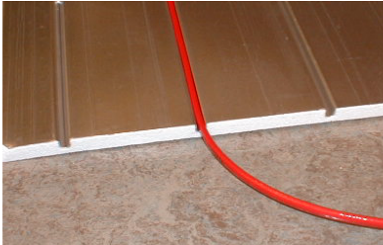
Fig. 15.4. Omega-plate i Al for selvregulerende varmekabler.
