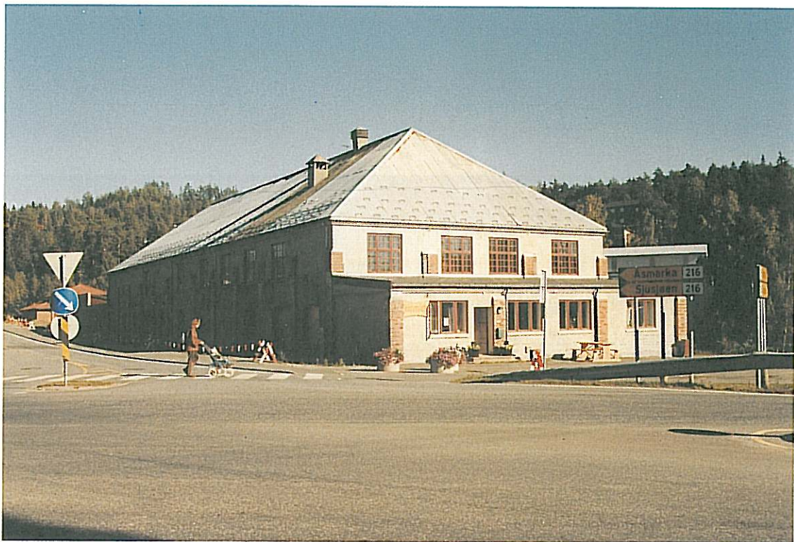
Garveriet på Moelv har skiftet rolle fra ubrukt fabrikkbygning til kulturhus og nærmiljøsenters. Bygningen er en del ombygd for å tjene det nye formålet.
