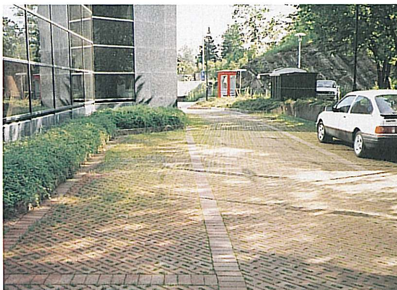
En parkeringsplass kan være grønn og permeabel. For å få til en bedre håndtering av overvannet i framtiden bør vi stille krav til utformingen av trafikkarealene. Det bør ikke være tillatt å foreta asfalteringer av f.eks. en bakgård uten at dette får konsekvenser for hva eieren betaler i vann- og avløpsavgifter (Landskapsarkitektene 13-3).
