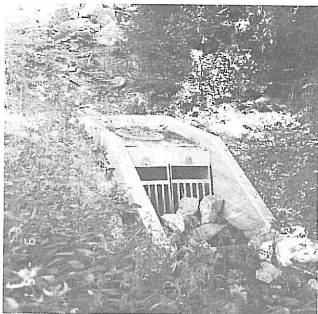
Allfor ofte ender det naturlige og åpne avrenningsystemet i en bekkelukking. Gjennomført på denne måten kan bekkelukkingen være en dårlig løsning teknisk, økonomisk, sikkerhetsmessig og miljømessig
