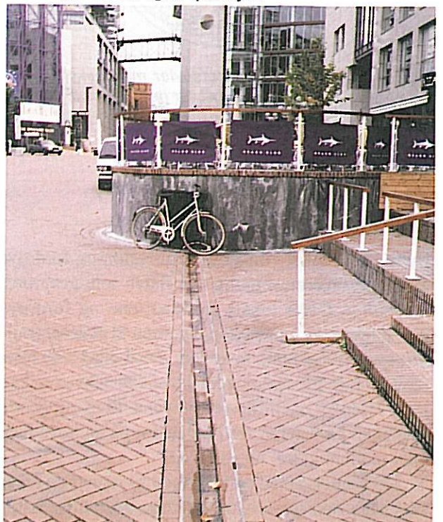
Åpne renner av denne typen med slake sider kan rengjøres i samme operasjon som dekket. Den slake sideskråningen gjør at rennen ikke er noe problem for gående og syklende. Eksempler på utforming av renner i en urban situasjon (Landskapsarkitekter 13-3)
