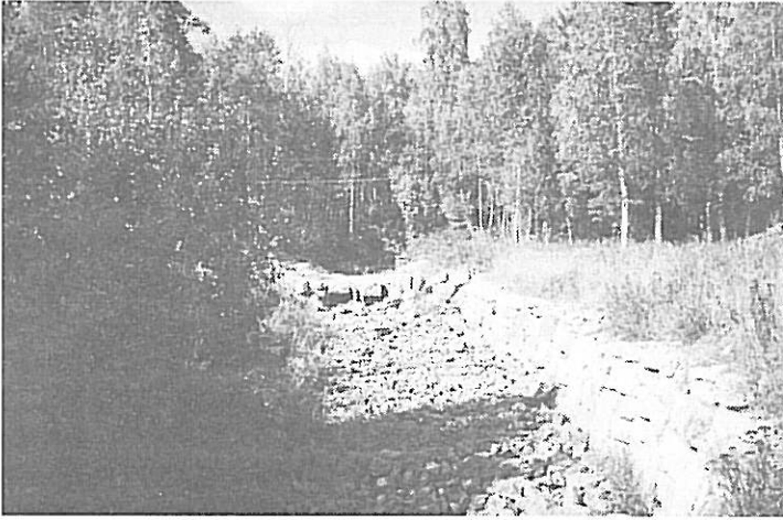
Øvre parti av bekken fører vann bare i flomperioder. Et åpent system som dette har stor kapasitet til å lede bort flomvann på en sikker måte.
