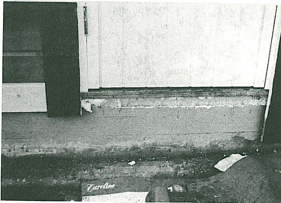
Fig. 1.3.2 c. Det er brukt dobbelt svill over sokkelementet. Svillen er forankret til ringmuren med bolter
