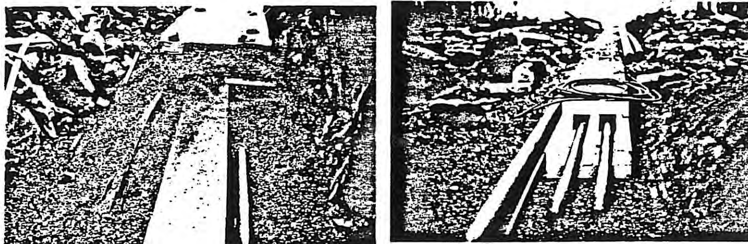
Fig 29b. Sekundærgrøfter med fjernvarme.
