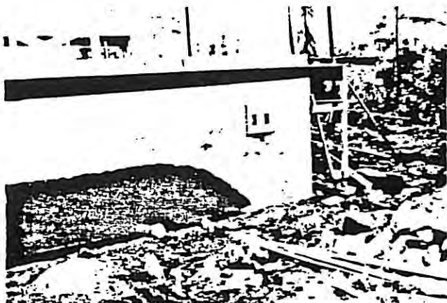
Fig. 26b. Målerskap for fjernvarme og el. med hovedbryter, plassert direkte over grøftetraseen.
