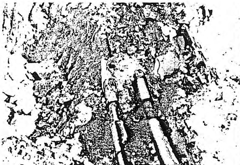
Fig. 7a. Preisolerte fjernvarmerør i separate grøfter på Brenna. Grøftene ble liggende lenge åpne ved rørskjøtene.
