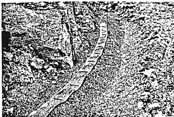
Fig. 17. Gatelyskabelen legges med en begrenset overdekning (0.35 m) i veigrøfta. For å utnytte veibredden i atkomstveiene er veigrøftene pukkfylte. Alle veigrøftene har drensledning.
