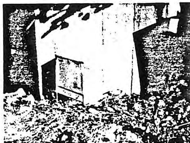
Fig. 25b. Alternativ plassering på hus, garasje e.l. i tilknytning til kabeltraseen og bruk av fellesfundament.
