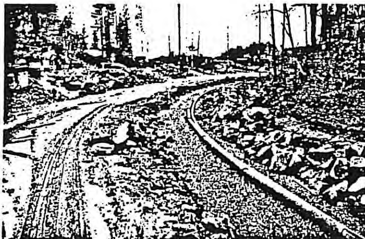
Fig. 9. Hovedvannledning og høyspentkabler i fellesgrøfter i bue langs samleveien. Det benyttes duktile støpejernsrør med strekkfaste skjøter.
