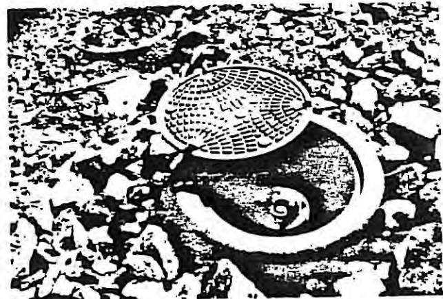
Fig. 22a. Nedgravd avstengningsventil på hovedledningen.
