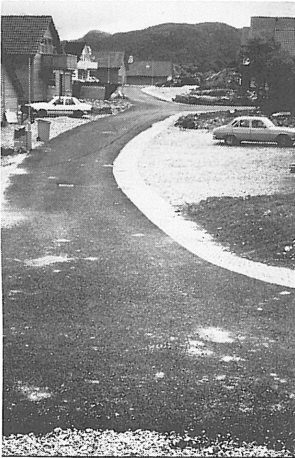
For å infiltrere overvannet er det benyttet permeabelt asfaltdekke på veiene
