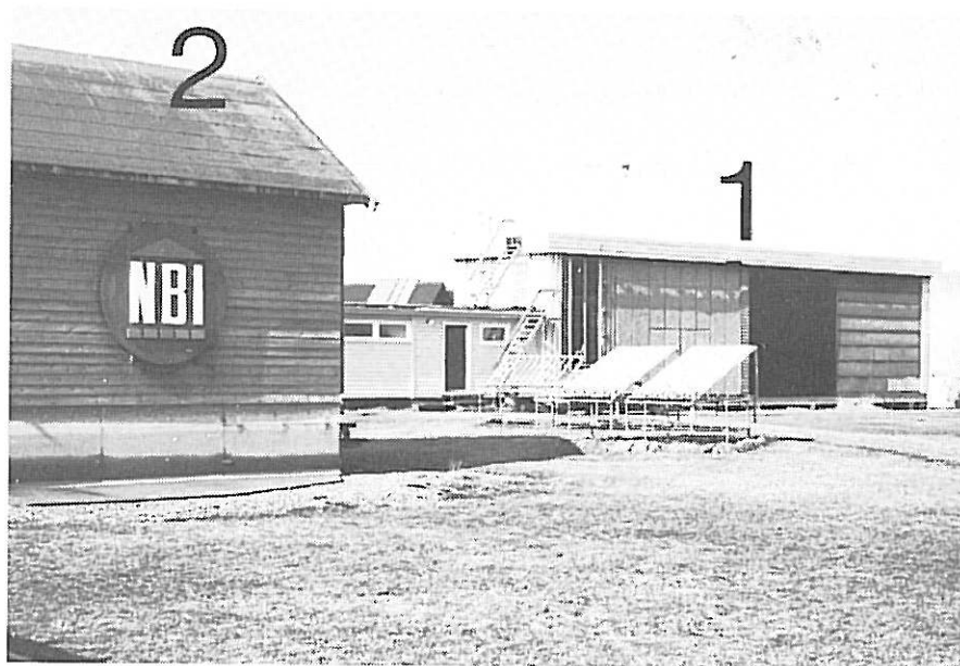
Fig. 11 Prøvehusfeltet på Tyholt. Hus 1: Østside av prøvehus med instrument- og servicerom. Hus 2: Prøvehus på hjul, kan dreies 360°.
