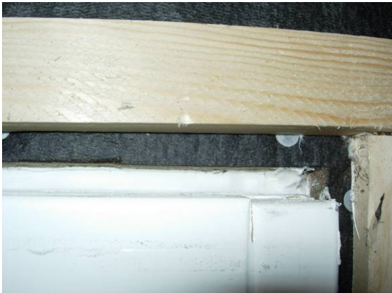
Figur 3.4.1. Fugemasse mot bunnfyllingslist
