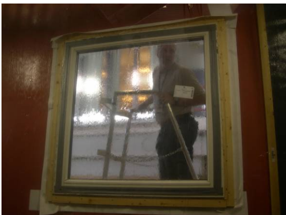
Figur 3.7.3. Prøvefeltet under slagregnsprøvingen
