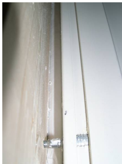
Figur 3.5.4. Tetting i vindsperrsjiktet forstyrres ikke av justeringshylsene
