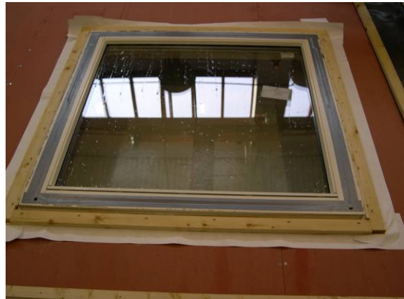
Figur 3.7.2. Vindsperreremse lagt utenpå plate
