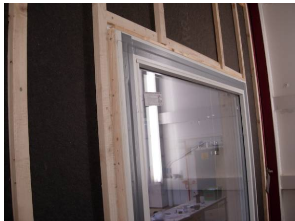
Figur 3.3.2. Vindsperreremse klemt med lekter mot vinduskarm
