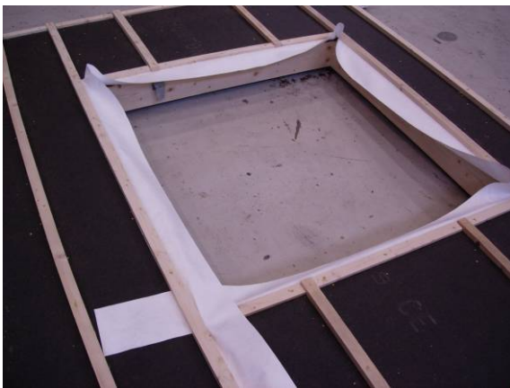
Figur 3.3.1. Vindsperreremse lagt utenpå vindsperreplate rundt vindusutsparing
