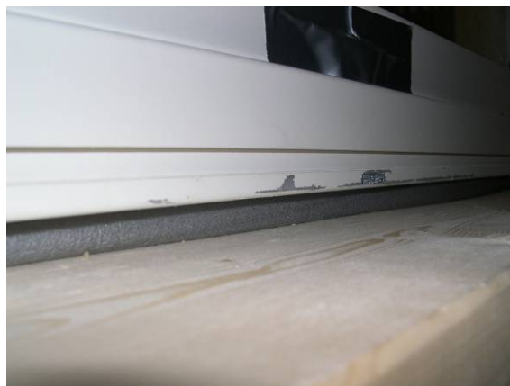
Figur 3.8.2. Fugemasse mot bunnfyllingslist
