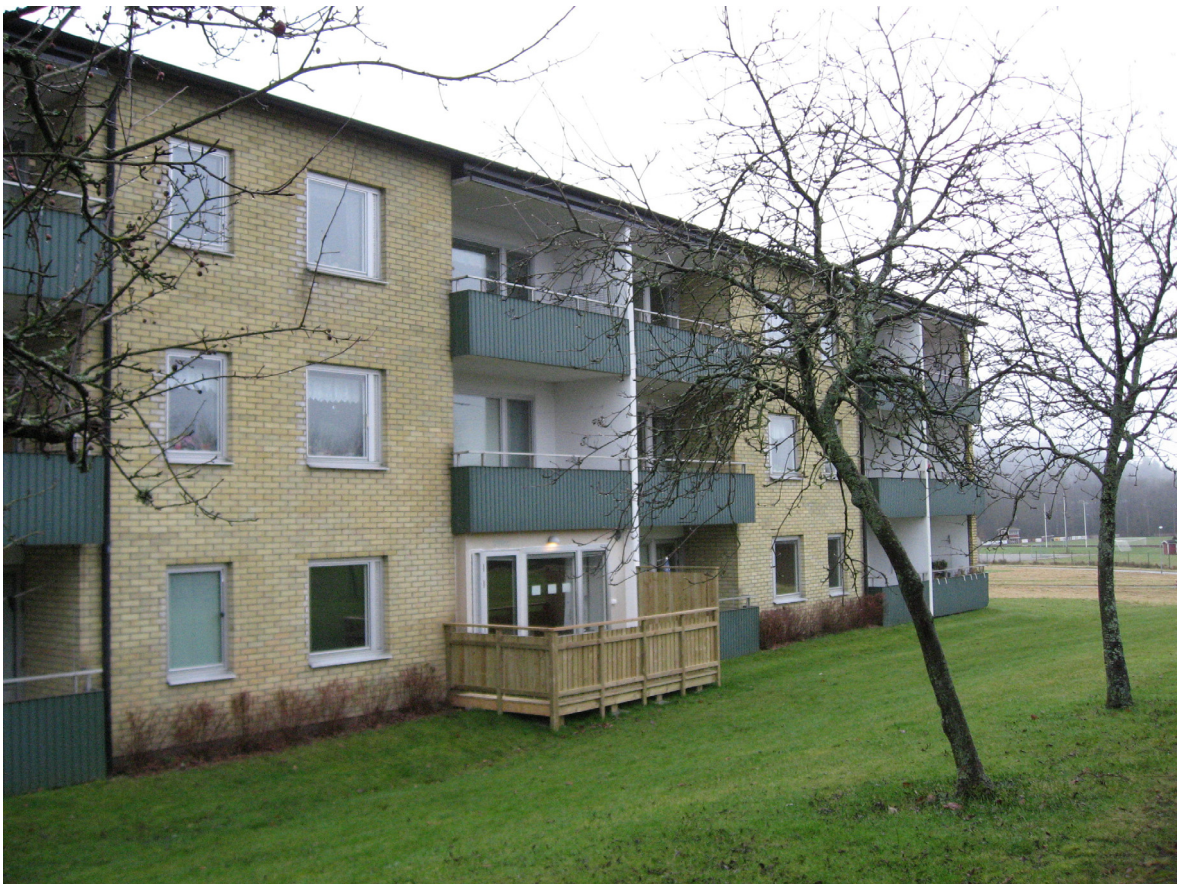
Brogården: Stortilt rehabilitering av lavblokker i Allingsås (Sverige) til nære passivhusstandard. Foto: SINTEF Byggforsk.
