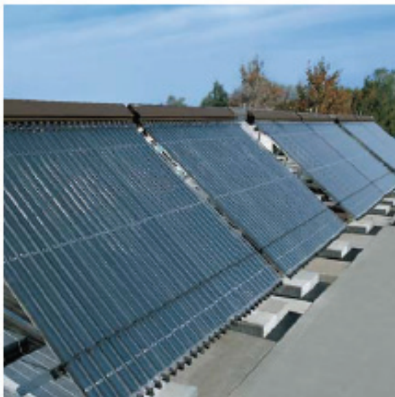
FIGUR 4-3 Solfangerpanel av typen vakuumrør.
