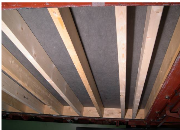
Figur 23 Undertaksfelt sett fra undersiden.
