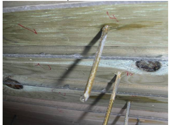
Figur 19 Vanndråper ved maskinspiker i trykkimpregnert materiale
