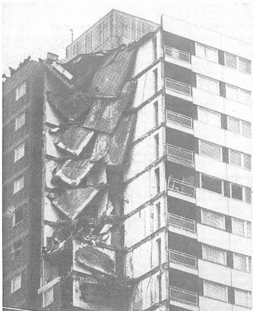
Figur 1. Ronan Point, London, 1968. Eksempel på eksplosjon i hjørnet av 18. etasje som forårsaket ras i alle husets 22 etasjer.
