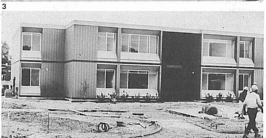
Fig. 1 Byggesystem Hercules. To bokstyper som kan stables horisontalt og en som reises vertikalt.
