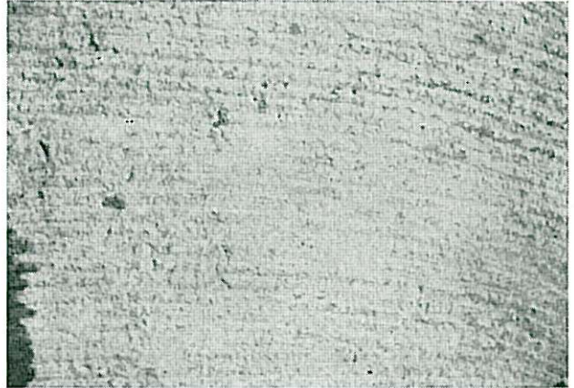
Fig. 10. Enkelte typer gulvbelegg krever et undergulv med ru overflate for at det skal kunne oppnås god heftfasthet. Som vist på figuren kan avrettingslaget kastes før det størkner.
