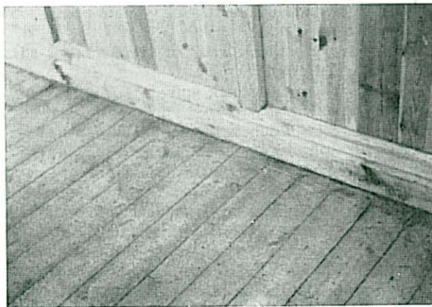
Fig. 16. Typisk eksempel på tregulv som bør sparkles eller slipes og forsynes med trefiberplater for det legges belegg.
