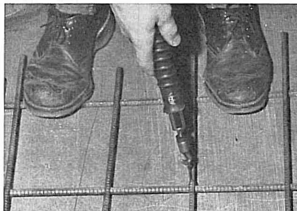
Fig. 2. Binde armering med sekketråd og pumpetrekker.
