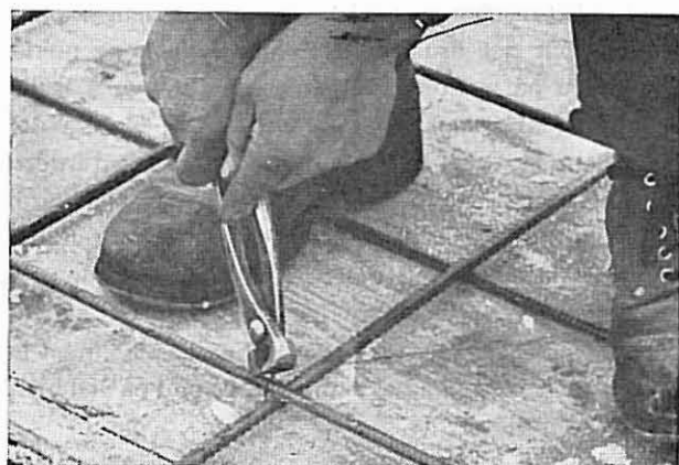
Fig. 1. Binde armering med tang.
