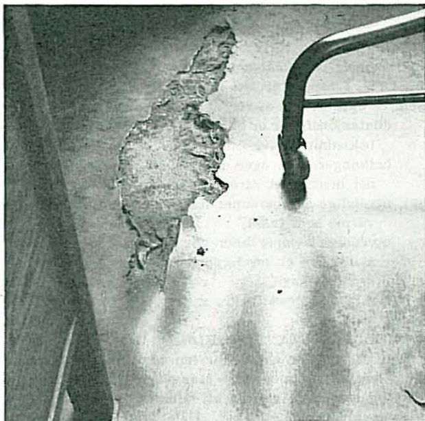
Fig. 3. Hjulet på kontorstolen har slitt istykker linoleumsteppet. Årsaken kan være at hjulet er for lite, at underlaget er for mykt eller at man har slurvet ved leggingen av teppet.
