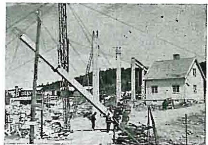
Fig. 12. Montering av søyler til kranbane.
