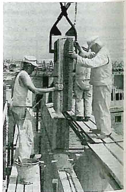
Fig. 6. Ydevægge af 23 cm. tykke elementer opstilles af ufglærte arbejdere + en let tårndrejokran.
