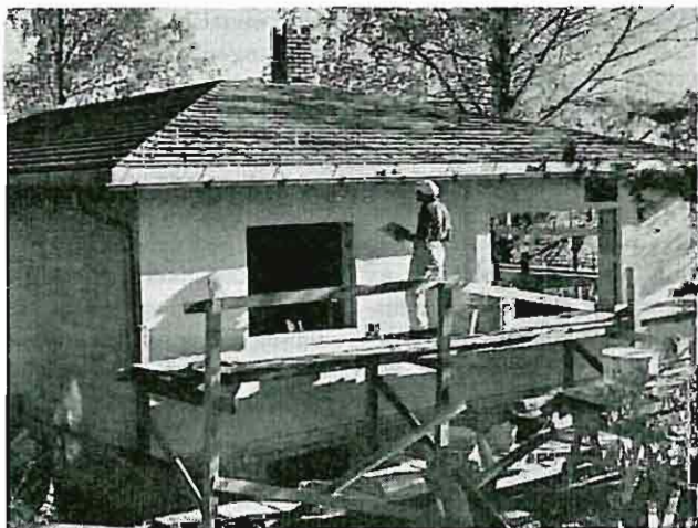
Fig. 3: Påføring av tynnpudd med stålbrett.
