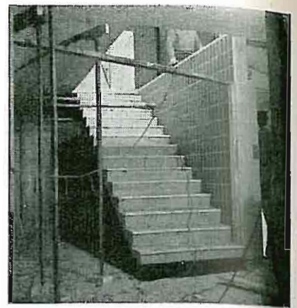
Fig. 8. Fackföreningarnas Byggnadsproduktion i Västerås tillverkar på fabrik en hel trappvägg i vilken stegen spännes in. Väggen placeras framför hiss-schaktet.
