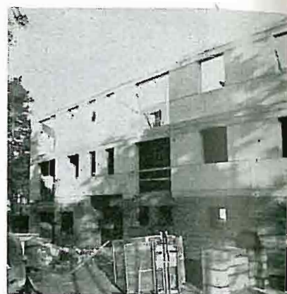
Fig. 2a. Ytterväggarna utföras av stora Siporex-skivor.
