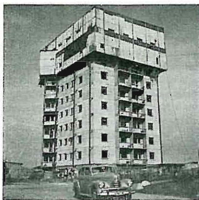
Fig. 4. Monteringen försiggår under ett «tält» som med hydrauliska domkrafter lyfts upp en våning i taget. Alla transporter sker med hjälp av traverser upphängda i det provisoriska taket.
