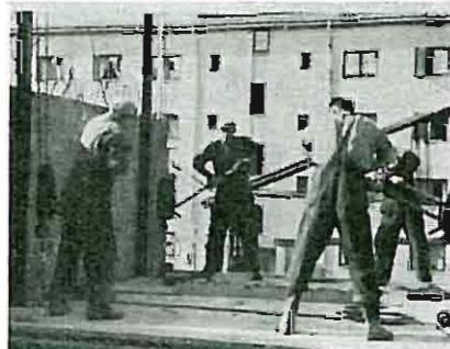
Fig. 8. Dekke-elementene jekkes opp ved hjelp av 4 hjelpemaster av stål.
