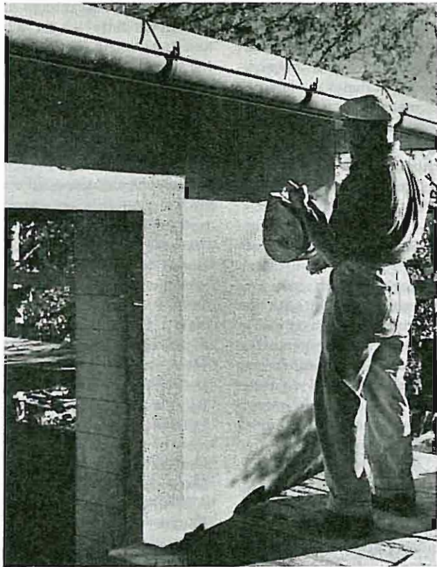
Fig. 2: Påføring av tynnpudd med stenkapparat.
