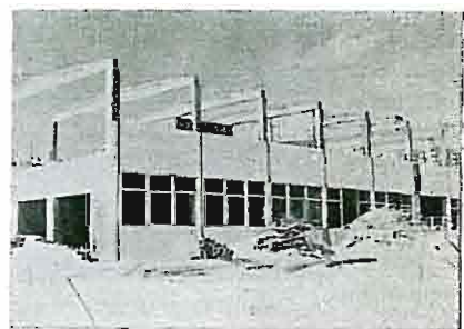
Fig. 10. Bjelkene montert på fabrikkbygningen på Grorud.
