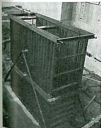
Fig. 3. De bärande väggarna monterar av färdiga element, gjutna i formpaket.
