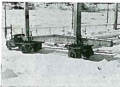
Fig. 9. Transport av forspent bjelke, vekt 3,7 t.
