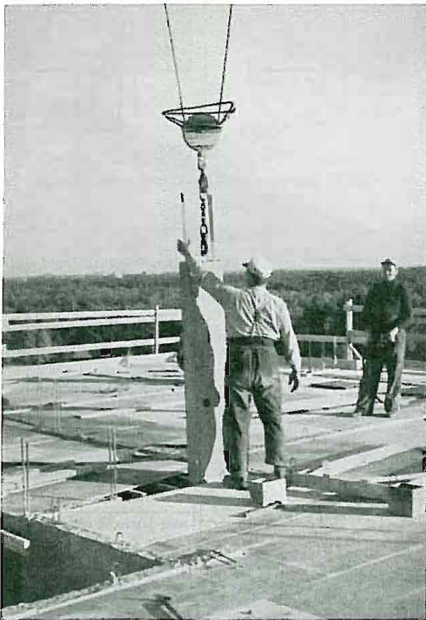
Fig. 6: Montering av betongelement.
