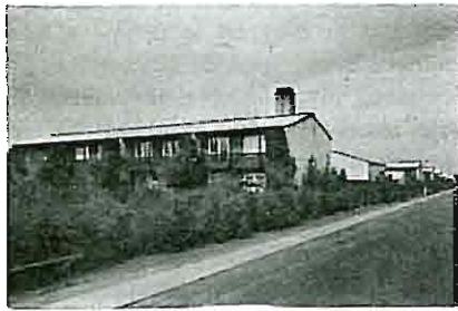
Fig. 5. Rækkehusbebyggelse, Engstrands Alle, 107 huse. Bygherre: Hvidovrebo. Administratør: Arbejderbo. Arkitekt: Eske Kristensen. Ingeniør: P. E. Malmstrøm. Beton-entreprisen: Larsen & Petersen.
