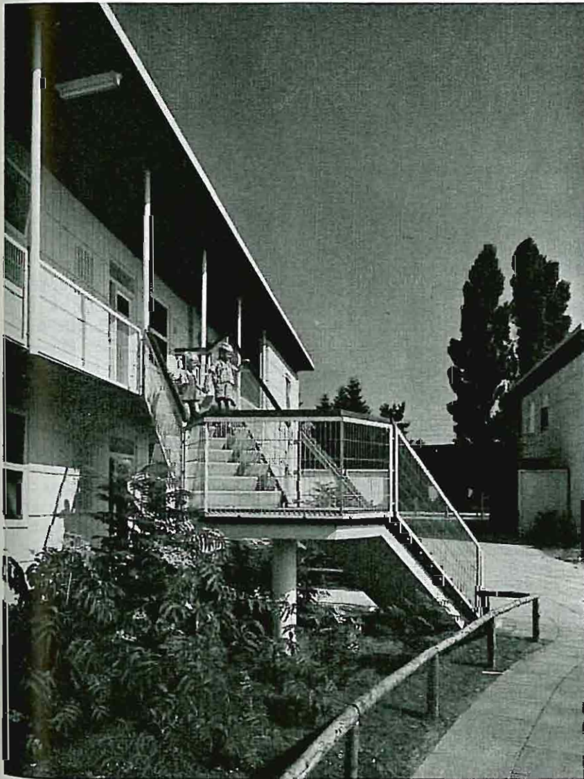
Fig. 12. Udvendig trappe til altangange.
