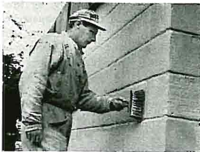
Fig. 1: Påføring av slemmet tympuss.
