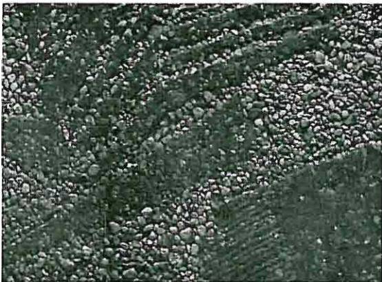
Fig. 2. Utsnitt av dekorativt felt injisert med sort cement og blåst på frihånd.
