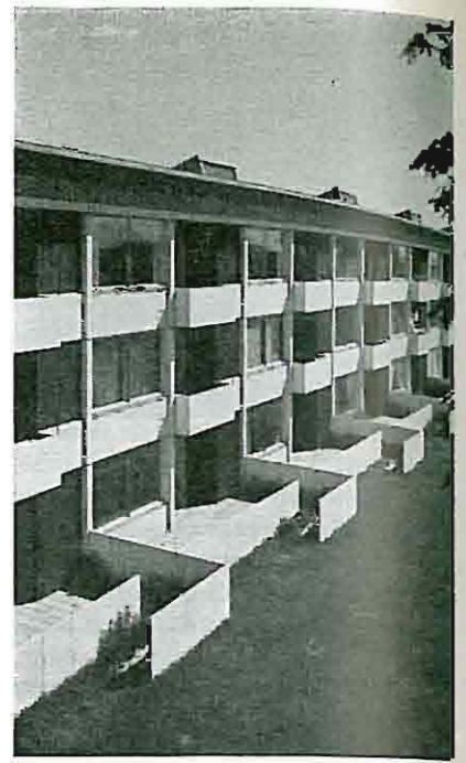
Fig. 14. Detailfoto af facadeparti med vindues- og altanbrystning med hvid forstøbning.
