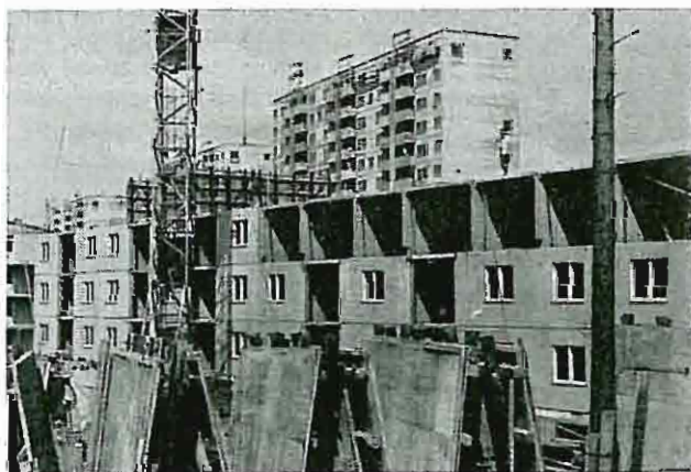
Fig. 1. Montering av råbygg. T. h. dekket montert på bærende tværvægger, T. v. oppsatt forskaling for bærende tværvægger. I forgrunnen forskallingslemmer.
