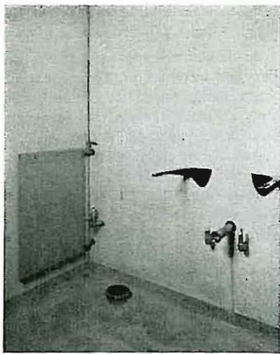
Fig. 9. Færdigfabrikerede vægge om baderum med hulafsetninger foretaget.
