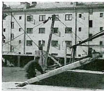
Fig. 3. Reising av veggelement ved hjelp av løftemast.
