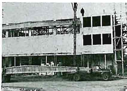
Fig. 11. Montering av bjelker på fabrikkbygningen på Etterstad.
