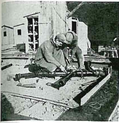
Fig. 10. I mallar på byggnadsplatsen eller på installatörens verkstad förtillverkas så stora enheter som möjligt.
