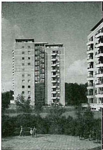
Fig. 1. Højskolebebyggelse på Bellahøj. Leflighedstallet: Ialt ca. 1250, 5 sociale boligselskaber. Bygherre for den viste bebyggelse er Arbejdernes kooperative Byggeforening. Arkitekt: Eske Kristensen. Ingeniør: Birch & Krogboe. Betonentreprisen: Christiani & Nielsen. Opført: 1951—55.
