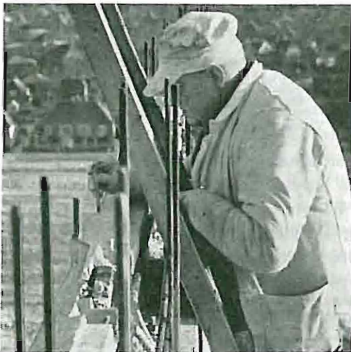
Fig. 3. Et fast punkt fra bakken føres ved teodolitt opp til gavlene, hvor det avsettes et blyantmerke.
