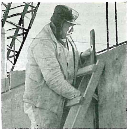
Fig. 5. På hver vegg føres et merke ned fra nylon-suorcn.
