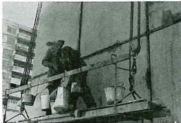
Fig. 4. Fuging av yttervegger fra hengestillas.
