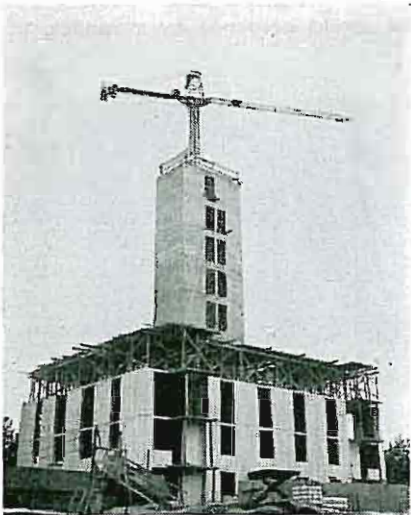
Fig. 7. Ohlsson & Skarne glidformsgjuter trapphusen och monterar där efter husstommen kring trapphuset.
