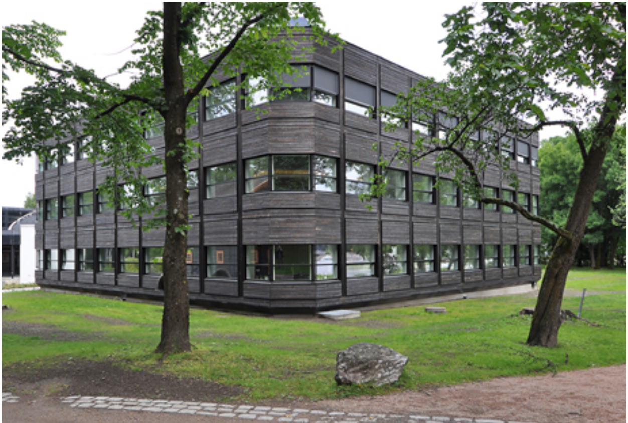
Figure 6.3 One of the office blocks of Powerhouse Kjørbo. Photo: Byggenytt.no.
