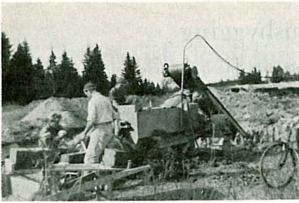
Fig. 3. Maskinfremstilling av leirblokker.
