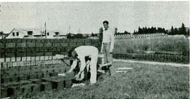
Fig. 4. Lagring av blokker.
