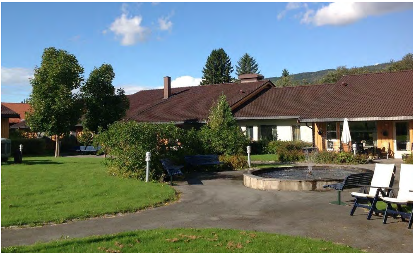
Fosslia bosenter sto ferdig bygd i 2002, arkitektkontor Arkideco AS.
