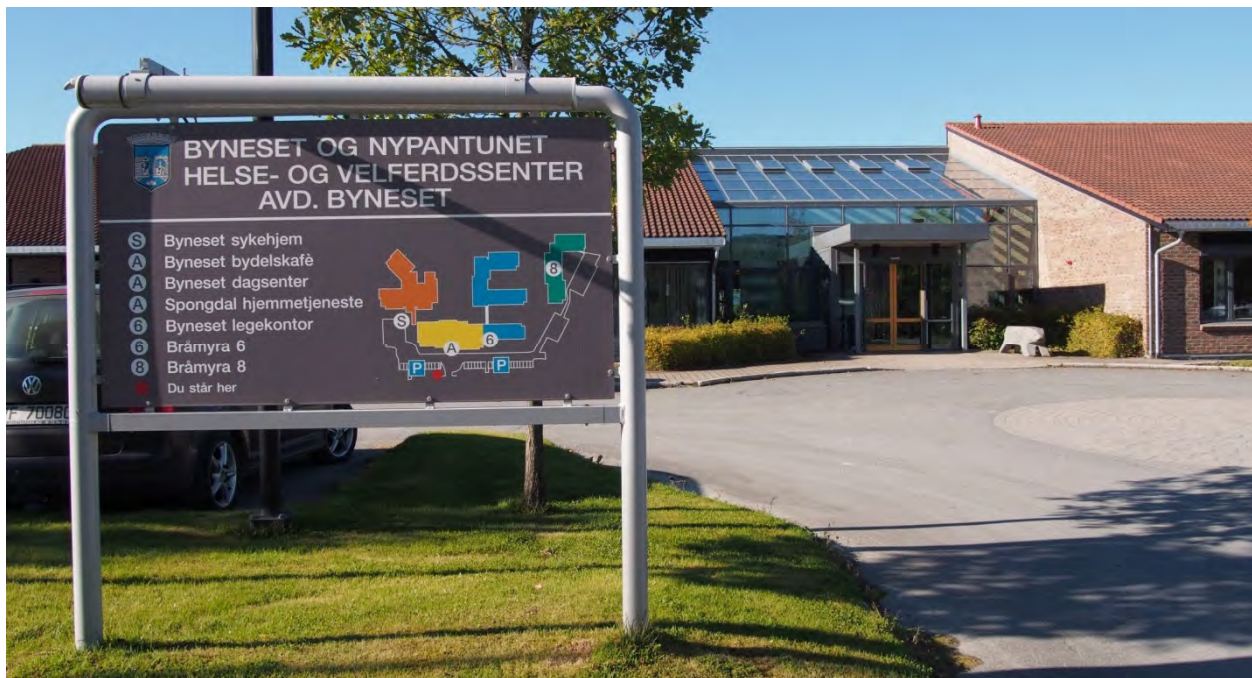
Byneset Helse og Velferdssenter er tegnet av Per Solems arkitektkontor AS og sto ferdig i 2003.
