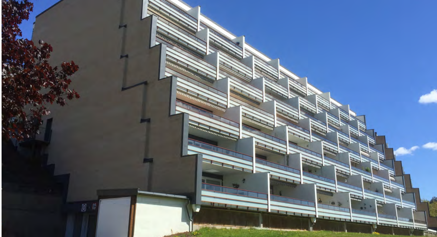
Vigvoll terrasse borettslag, «bakside», etter oppgradering. Foto: Sørlandet boligbyggelag
