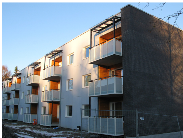
Etter oppgradering, balkongfasade (Kilde: SINTEF Byggforsk)
