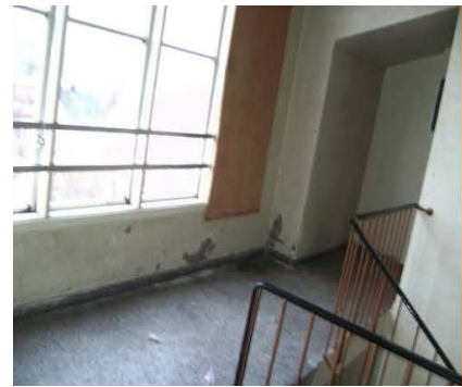
Oppgang i "Svingen" før oppgradering. (Kilde: Avid.)
