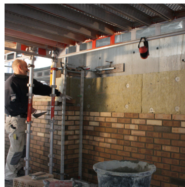
Inngangsparti under oppussing (Kilde: SINTEF Byggforsk)
