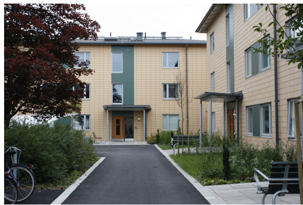
Etter oppgradering. (Kilde:SINTEF Byggforsk)
