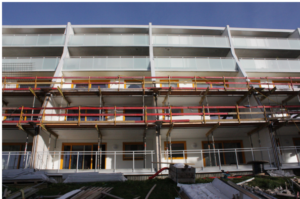
Under oppgradering. (Kilde:SINTEF Byggforsk)
