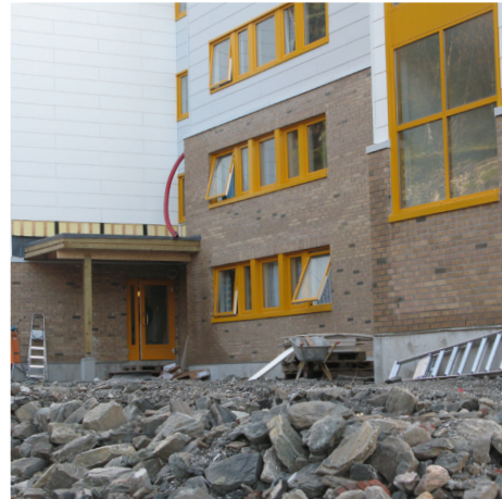
Vanskelig inngangssituasjon for beboerne under rehabiliteringen. Midlertidig ble garasjene i kjelleretasjen brukt som hovedinngang. (Kilde: SINTEF Byggforsk)
