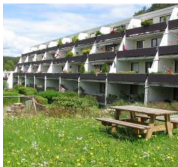
Før rehabilitering terrasser (Kilde: SINTEF Byggforsk)
