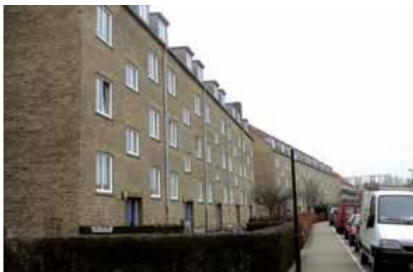
Før oppgradering. (Kilde:SINTEF Byggforsk)
