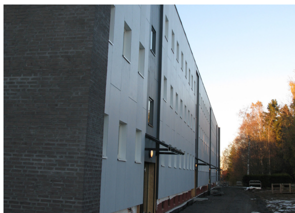
Etter oppgradering. (Kilde: SINTEF Byggforsk)
