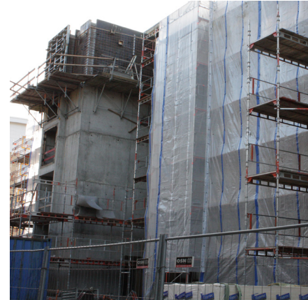
Fasaden under rehabilitering (Kilde: SINTEF Byggforsk)
