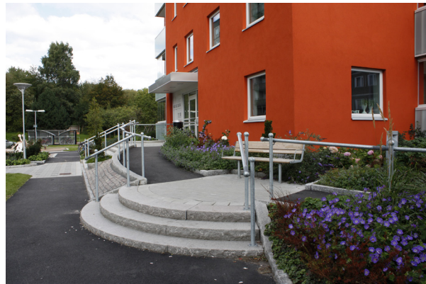
Nytt inngangsparti. (Kilde: SINTEF Byggforsk)
