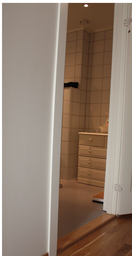
Lav terskel inn til badet i en av de nye toppleilighetene. (Kilde: SINTEF Byggforsk)
