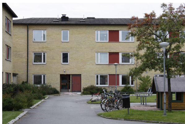
Før oppgradering. (Kilde:SINTEF Byggforsk)
