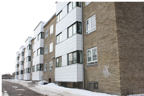
Etter oppgradering. (Kilde:SINTEF Byggforsk)
