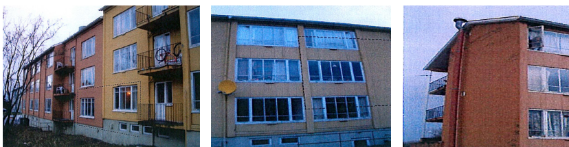
Overgang mellom veranda og stue, etter oppgradering. (Kilde: Rådgivende ing.)
