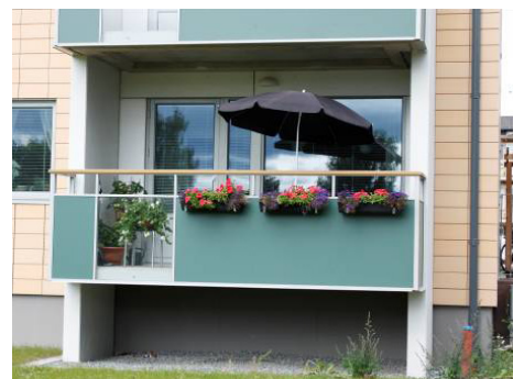
"Innredet" ny balkong. (Kilde: SINTEF Byggforsk)
