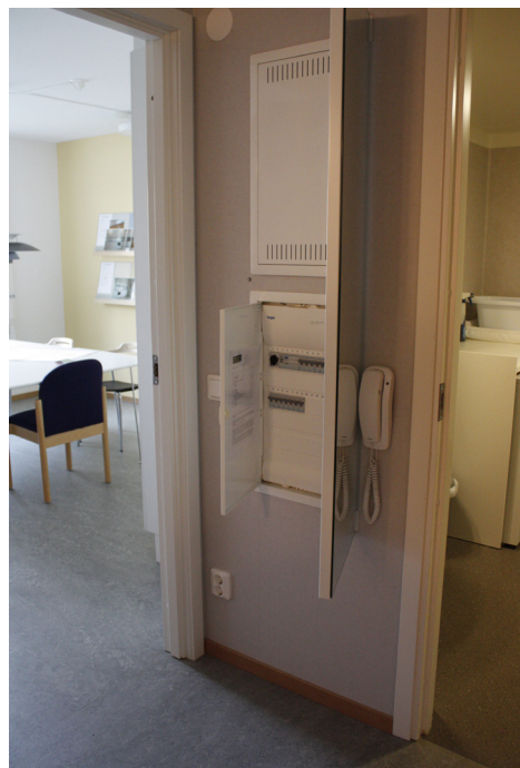
Trinnfrihet, samt portelefon og sikringskap i lav høyde bak speil i entreen. (Kilde: SINTEF Byggforsk)
