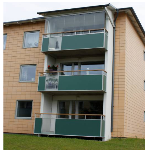
Balkonger etter oppgradering. Beboerne kunne velge mellom åpen eller innglasset. (Kilde: SINTEF Byggforsk)
