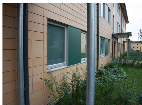
Fasade med keramiske plater som kledning (Kilde: SINTEF Byggforsk)
