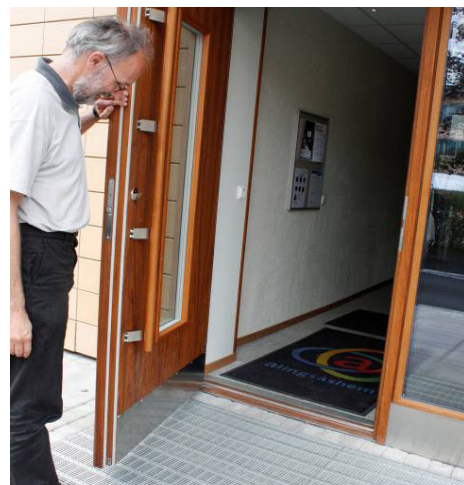
Lave terskler inngang. (Kilde: SINTEF Byggforsk)
