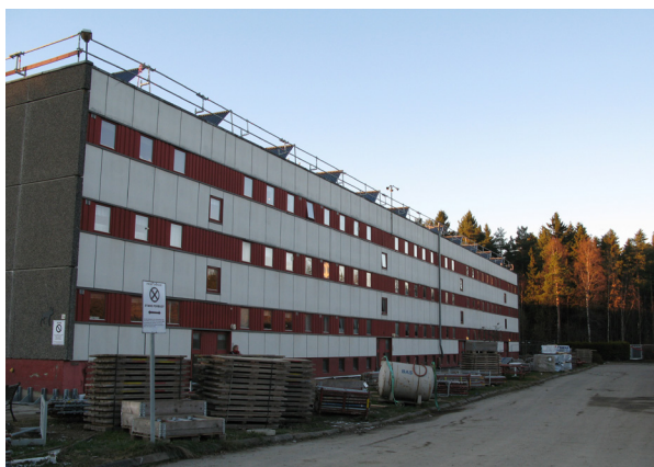
Før oppgradering. (Kilde: SINTEF Byggforsk)
