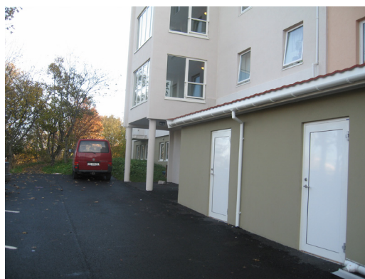
Fasade mot bakgård "Svingen" (Kilde: Øyen, SINTEF Byggforsk)
