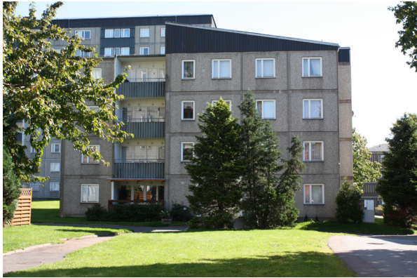
Før oppgradering: Bygningen så tidligere ut som de andre blokkene i området. (Kilde: SINTEF Byggforsk)
