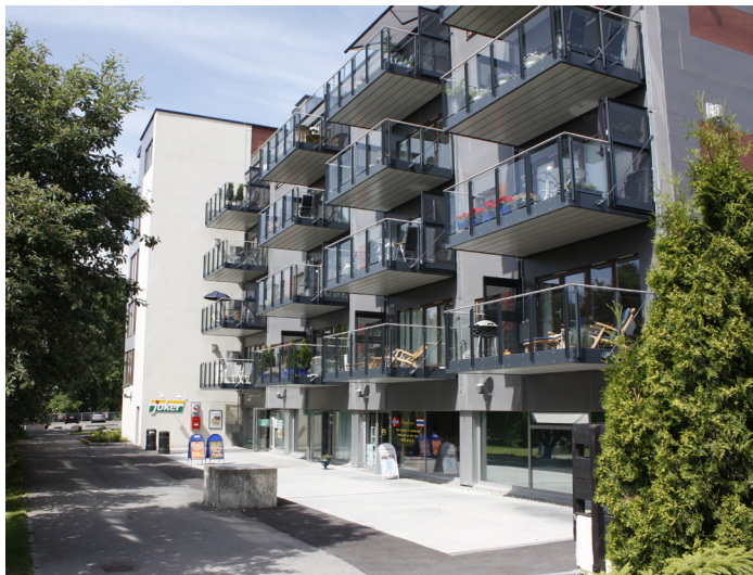
Bilde etter rehabilitering, fra boligblokkens sørside, med påhengte balkonger (Kilde: SINTEF Byggforsk)
