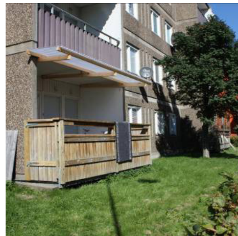
Balkonger før rehabilitering (Kilde: SINTEF Byggforsk)
