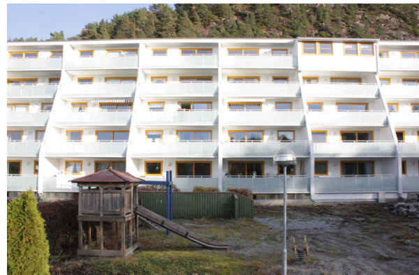
Etter oppgradering. (Kilde:SINTEF Byggforsk)
