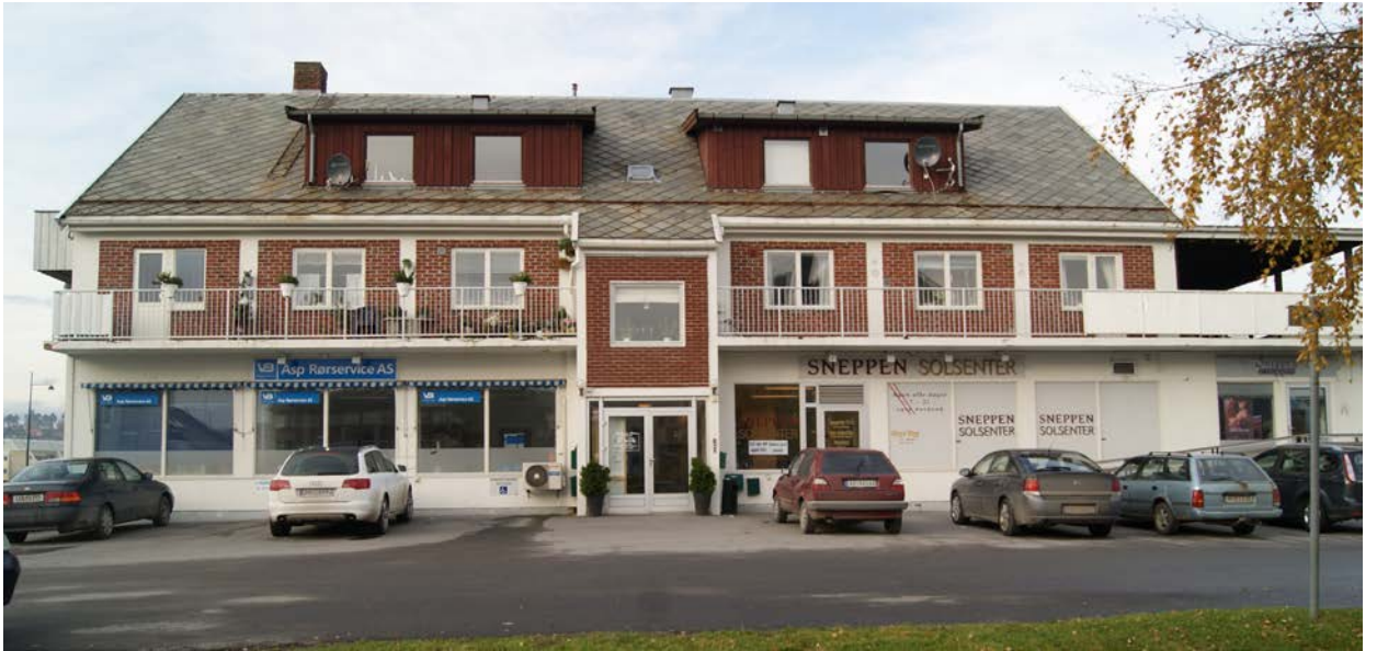
Eksisterende fasade. Foto: SINTEF Byggforsk
