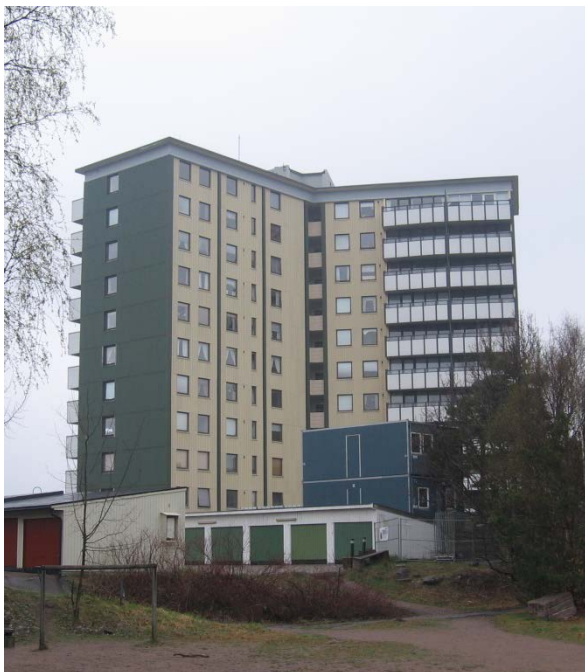
Fasade før oppgradering. Foto: Sørlandet Boligbyggelag
