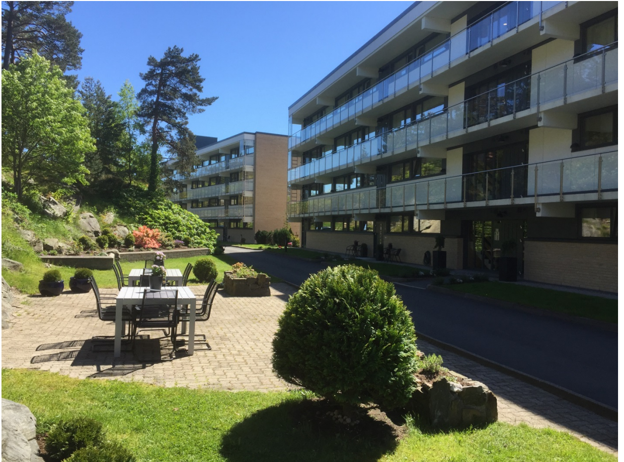
Ny fasade. Foto: Sørlandet Boligbyggelag (SBBL)
