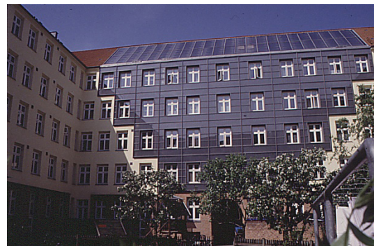
København. Mørkfarget puss bak gjennomskinnelig isolasjon som er dekket av glass. Energi design: Cenergia Energy Consultants.
