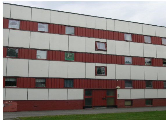
Fasadene skal estetisk oppgraderes og etterisoleres med nye 20 cm mineralull. Kilde: Arkitektskap AS
