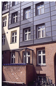
København. Mørkfarget puss bak gjennomskinnelig isolasjon som er dekket av glass. Energi design: Cenergia Energy Consultants.
