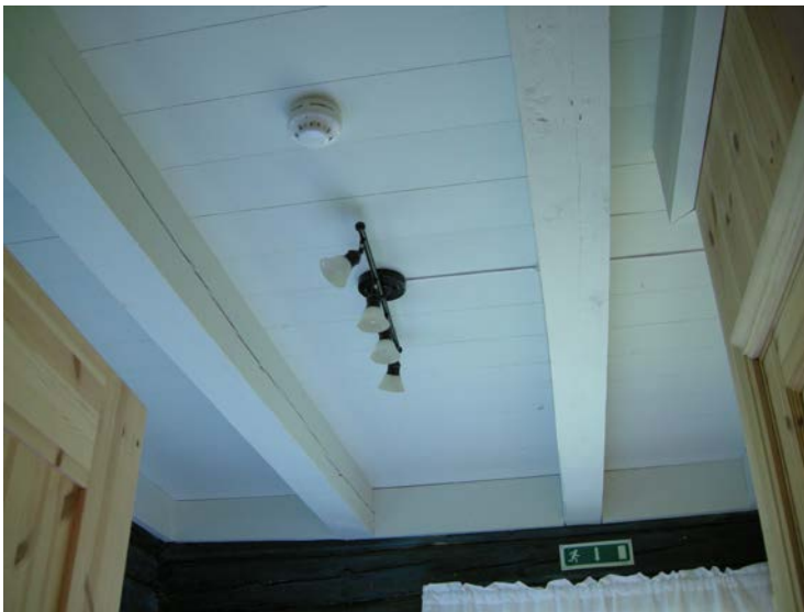
Figur 2.1 b. Eksisterende himling i "Storstue fra Hagen"
