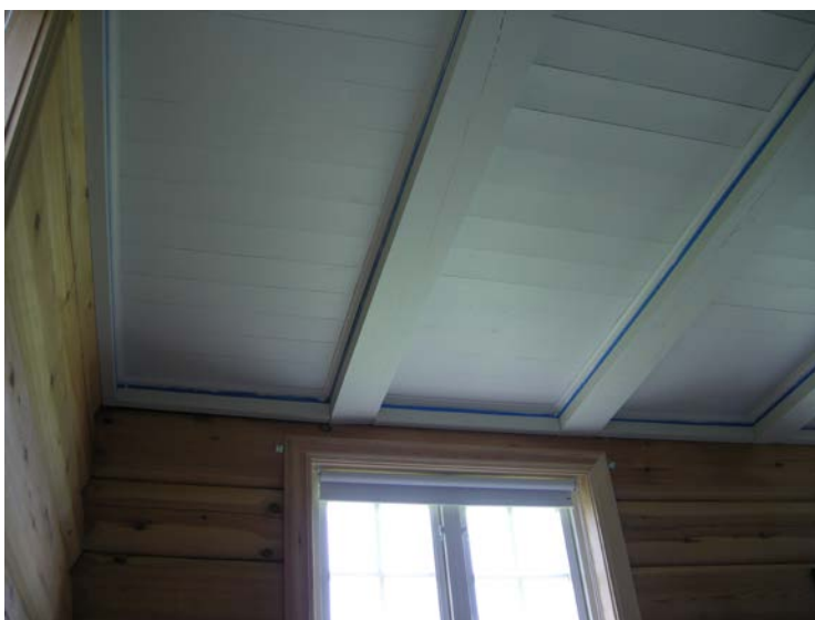
Figur 2.3 c. Himling etter gjennomført tiltak i "Hovedhuset"
