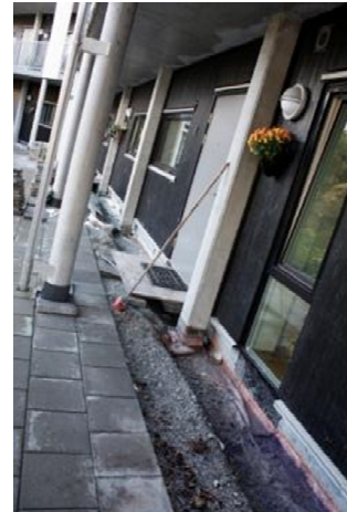
Utbedring av membranen ved terskelløsningen.
