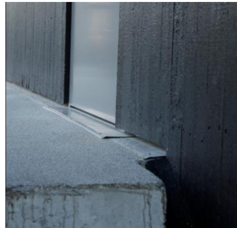
Inngangsdør fra svalgang. Et dørkebeslag er brettet utover på svalgangen uten å være slisset inn i betongen.
