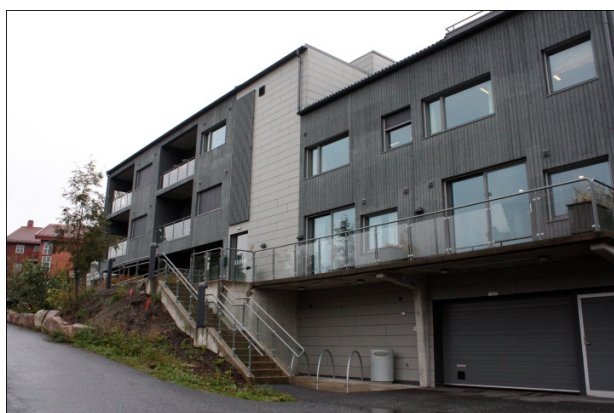
Bolighuset sett fra veien. Balkongene til venstre ligger innenfor bygningskroppen og er godt skjermet mot klimapåkjenninger.
