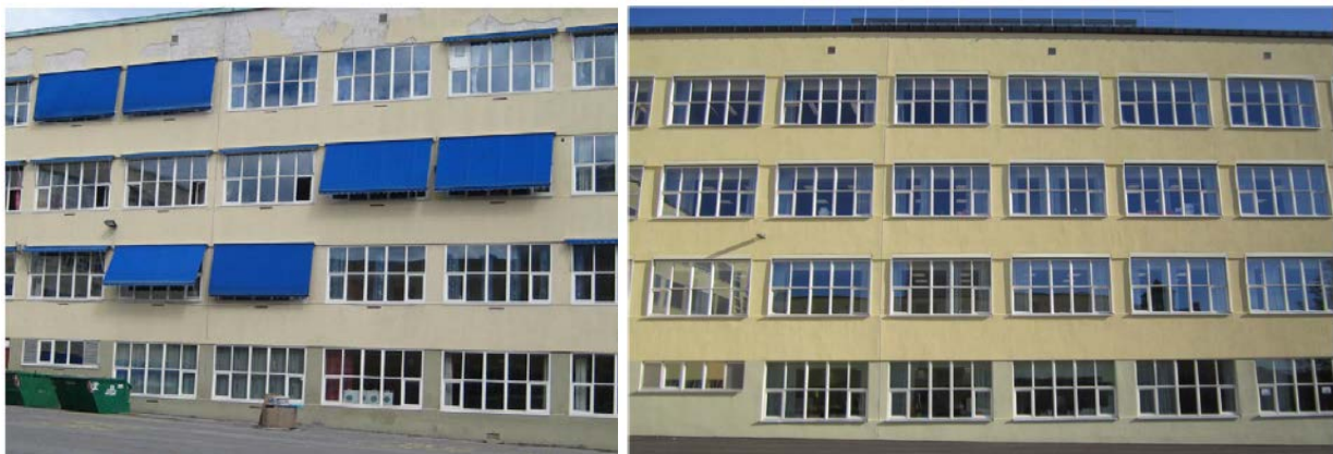
Figur 12 Sinsen skole i Oslo: Fasade før og etter oppgradering med ny isolasjon. Foto: Per Spjudvik, Multiconsult.
