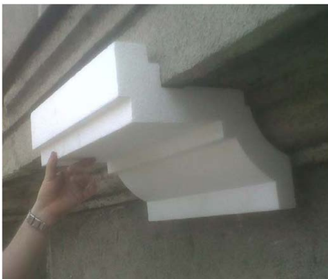
Figur 53 Gesimsprofil av EPS. I eksemplet er eksisterende gesims bevart, og EPS-profilen er plassert over den med samme utvendig utforming. For å gi mindre kuldebro, bør elementet være tykkere enn 2 cm som vist i skissen til høyre. Produsent: Austrotherm. Kilde: Sanierung mit PH-Technologie (2013).
