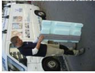
Første lag: 100 mm isolasjon med luftkanaler
