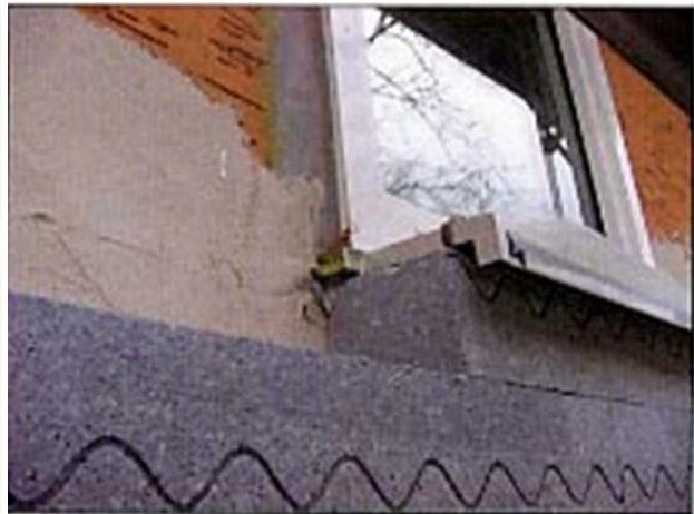
Figur 50 Lufttetting rundt vindu med butylbånd mot eksisterende utvendig puss som lufttett sjikt. Der det er nødvendig, utbedres pusslaget med sparkelmasse som kan føres over butylbåndet (se høyre bilde). Kilde: Protokollband Nr. 24 (2003).
