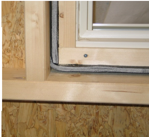
Figur 49 Lufttetting rundt vindu med selv-klebende, ekspanderende fugebånd som festes på karm. Etter monteringen starter det komprimerte båndet å ekspandere slik at vindusfugen tettes kontrollert og sikkert. Ved full ekspansjon oppnås svært god luft- og regntetting samt en fullisolert fuge med U-verdi på 0,7-0,8 W/m 2 K (gjelder tilsvarende variant). Løsningen kan brukes i tre- og mur/betongvegger mot smyget. Foto: Isola.
