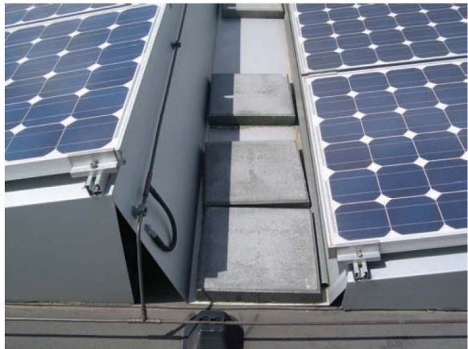
Figur 42 Solcellepaneler på små, lette stativer med vindskjerming. Ballasten er plassert på skjermingen som vist. Foto: SINTEF Byggforsk. Kilde: Flate tak (2008).
