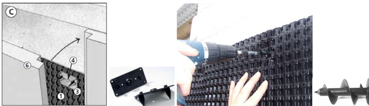
Figur 47 Innfestingsløsninger for tetting ved grunnmur og kjellervegg. Til venstre: Montering av isolasjon på knastplater med Platon isolasjonsholder (3). Til høyre: Montering av knastplater utenpå isolasjon av EPS/XPS ved grunnmur med Platon festeskru. Kilde: Isola.
