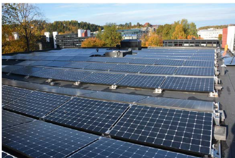
Figur 43 Powerhouse Kjørbo i Sandvika: Stativer med øst-vest-monterte solcellepaneler og lav helning gir god utnyttelse av takareal uten skygge. Stativet har lav linjelast på grunn av breie skinner på beskyttelsessjikt. Lite utsatt for vind og lite behov for ballast. Foto: Asplan Viak. Illustrasjon: Knubix. Kilde: Bernhard (2013).
