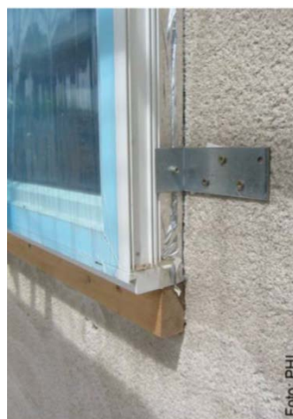
Figur 51 Hjelpemidler for montering av vinduer. Til venstre: Justerbar montasjeskinne for vindu plassert lenger ut i isolasjonssjiktet. Til høyre: Enkel håndverksmessig støttefirkant av tre for å gjøre det lettere å montere vinduet med stålvingler. Noe kuldebro kan aksepteres hvis det er god isolasjon foran på undersiden av vinduet. Viktig: Bruk vinkler bare i nødvendig antall og størrelse. Langsgående stålskinner vil gi stor kuldebro. Kilde: Altbauhandbuch (2009).
