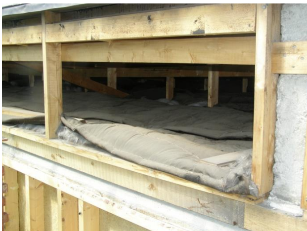
Figur 35 Myhrerenga på Skedsmokorset: Oppføret tretak før oppgradering med tørr trekonstruksjon i god tilstand og luftet hulrom over 10 cm eksisterende isolasjon (fasadekledningen er fjernet). Foto: SINTEF Byggforsk.
