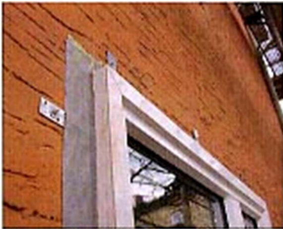
Figur 50 Lufttetting rundt vindu med butylbånd mot eksisterende utvendig puss som lufttett sjikt. Der det er nødvendig, utbedres pusslaget med sparkelmasse som kan føres over butylbåndet (se høyre bilde). Kilde: Protokollband Nr. 24 (2003).
