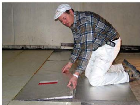
Figur 4 Golv på grunnen med vakuumisolasjon, fra en rehabilitert barnehage i Ulm, Tyskland. Golvhøyden skulle ikke økes på grunn av eksisterende dører, og underliggende betong skulle ikke hogges opp. Eksisterende 66 mm sementgolv og 30 mm isolasjon ble erstattet av en ny golvkonstruksjon, hvor vakuumisolasjonspaneler ligger beskyttet mellom isolasjon av polyuretan og mineralull. U-verdien ble forbedret fra 0,96 til 0,18 W/m 2 K. I skjøtene mellom panelene oppstår imidlertid kuldebroer, som ble beregnet til 0,0061 W/mK. Dette høres lite ut, men siden det er mange meter med skjøter, gir det et betydelig påslag. Inkludert dette kuldebropåslaget øker U-verdien etter oppgradering reelt til 0,21 W/m 2 K. Kilde: IEA SHC Task 37 (2011).
