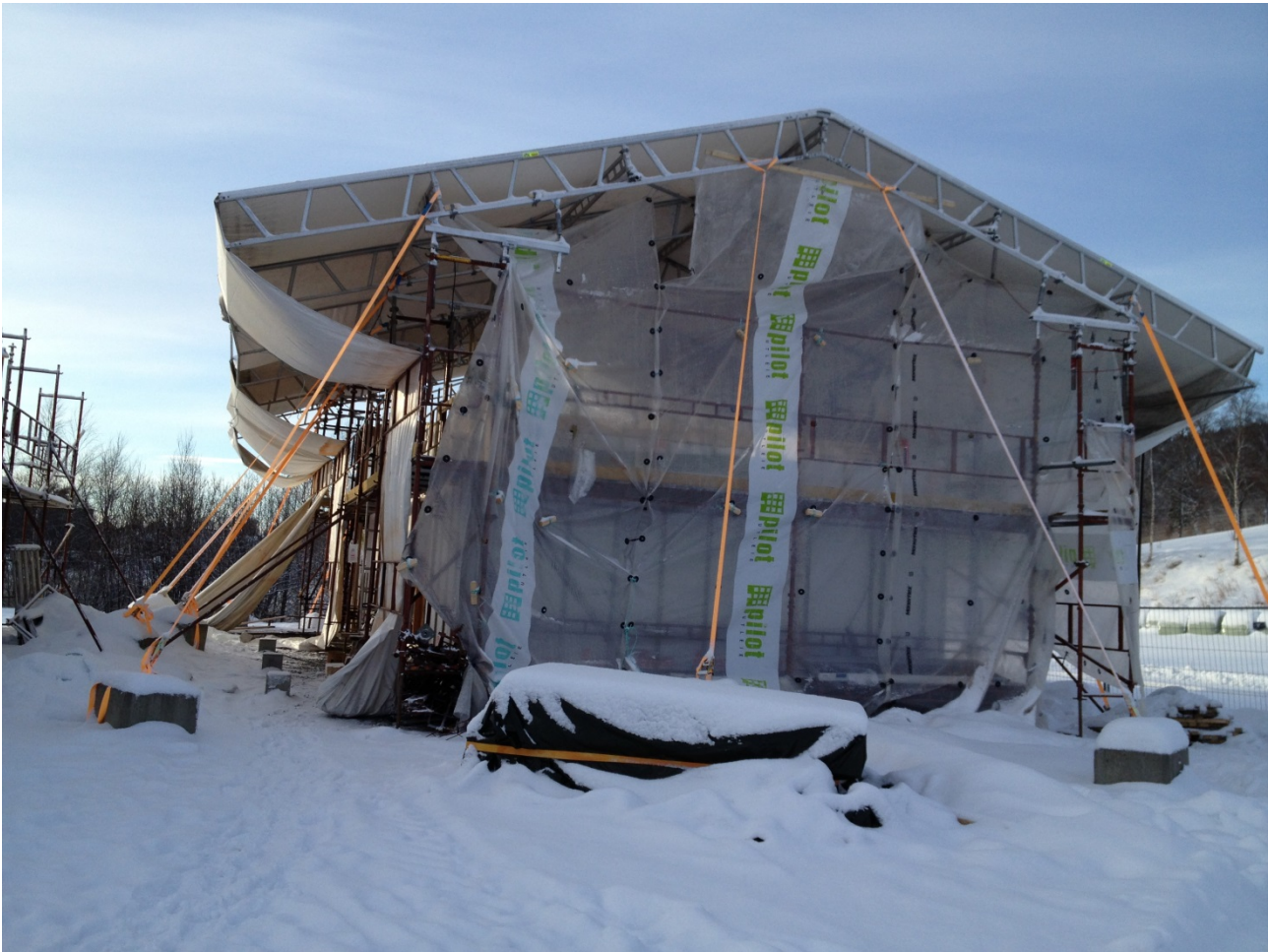
Den første rimelige boligen som ble bygd under telt av byggfagelever på Vassneset i Åfjord. Bildet er fra februar 2013. Foto: SINTEF Byggforsk/Ruth Woods
