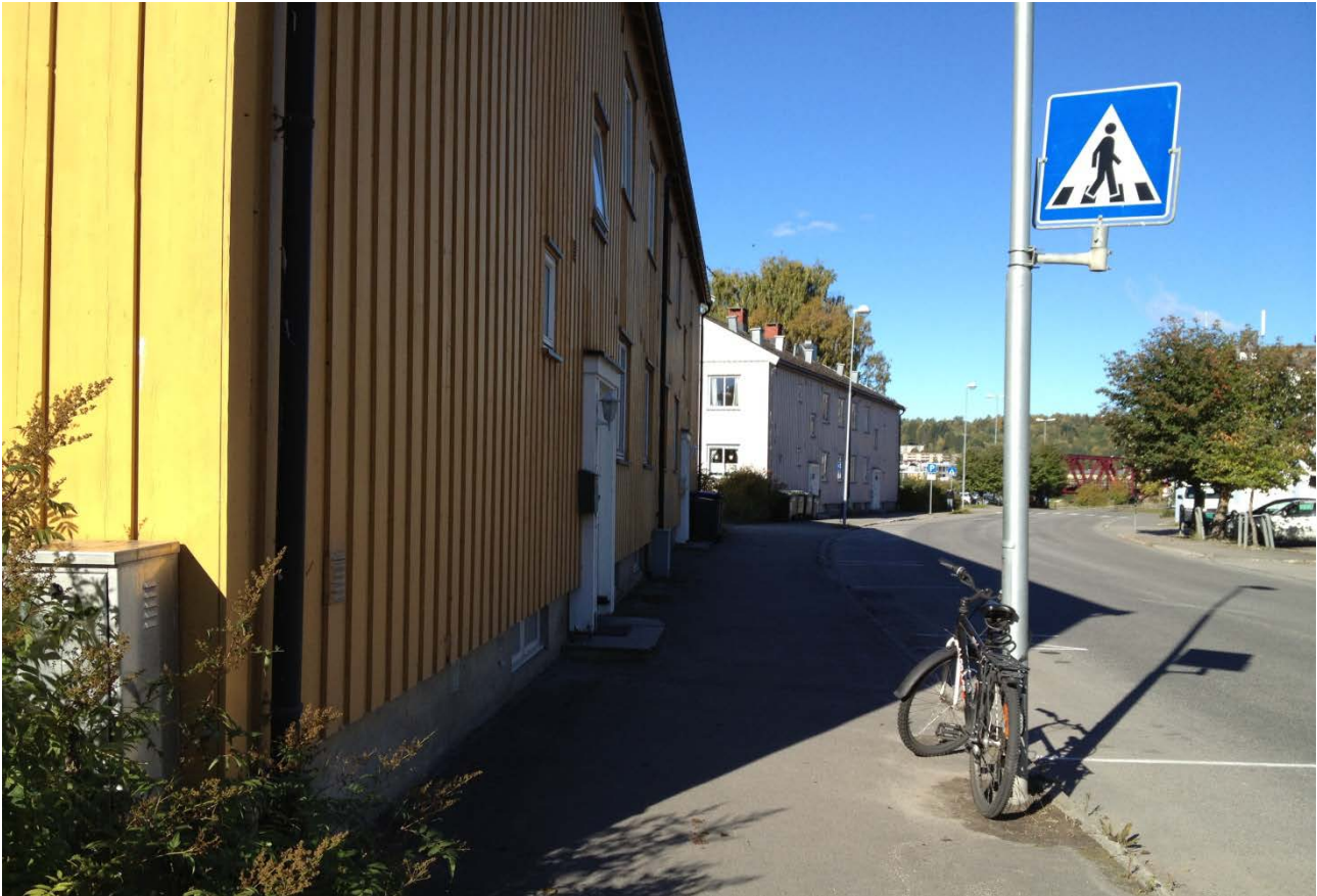
Fasaden av den kommunale boligen sett fra Strandveien høsten 2013. Foto: SINTEF Byggforsk / Ruth Woods
