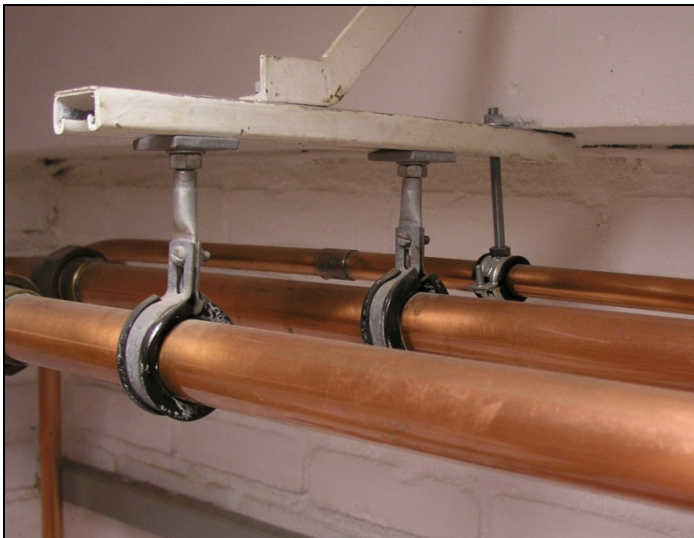
Figur 5.3: Klamring av kobberrør. Oppheng av flere rør i felles skinne Foto: SINTEF Byggforsk
