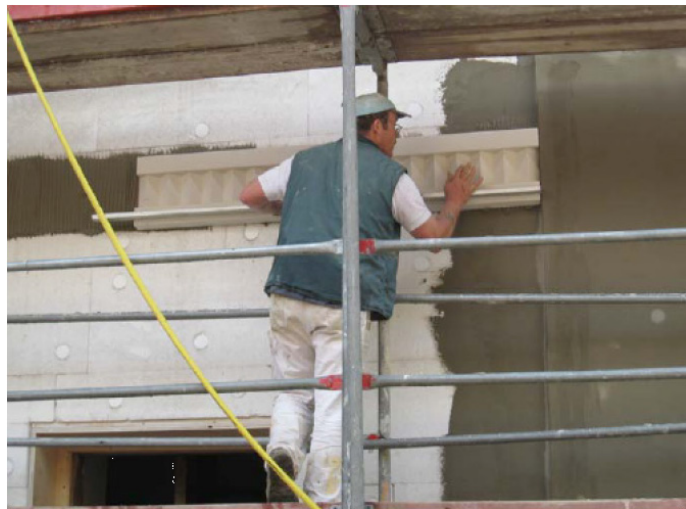
Figur 7 Montering av ny gesims utenpå ny, utvendig isolasjon.
