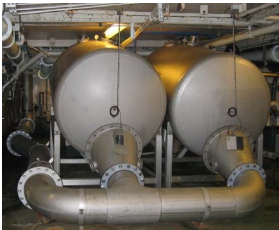
Figur V1.3: Vekslende vakuumentanker plassert under dekk.
