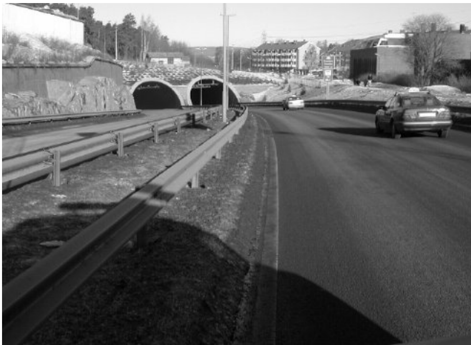
Figur 18. Dagsone utenfor Svartdalstunnelen - kjørebane mot sentrum til høyre
