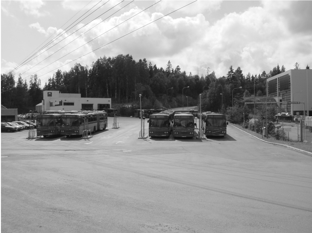
Figur 2. Bussoppstillingsplass på Klemetsrud, Oslo. Plassen er bygget opp med forsterkningslag av resirkulert tilslag 38-120 mm
