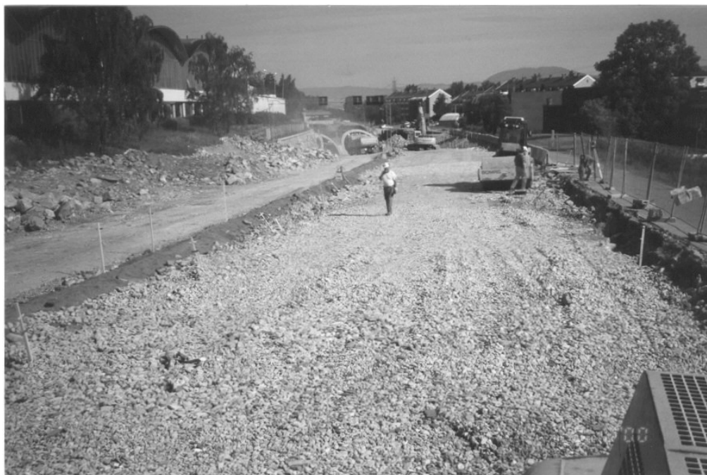
Figur 7. Ferdig utlagt forsterkningslag av resirkulert tilslag 38-120 mm i dagsonen mellom Ryenkrysset og Svartdalstunnelen (tunnelen sees i bakgrunnen)
