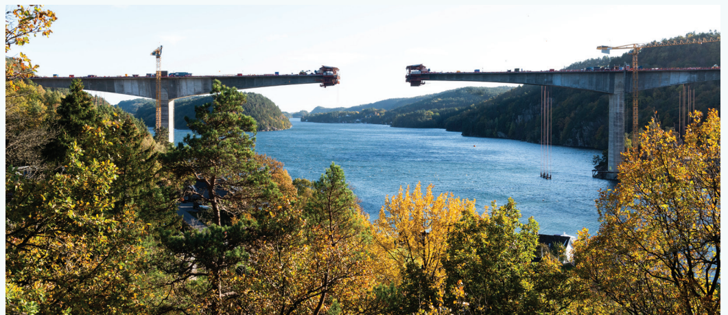
Bygging av E39 Trysfjordbrua mellom Kristiansand og Mandal.
