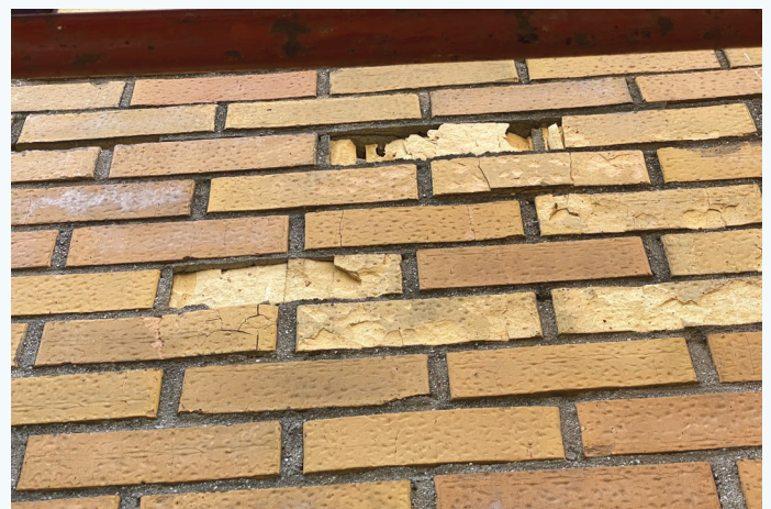
Frostskafer på teglforblending.
