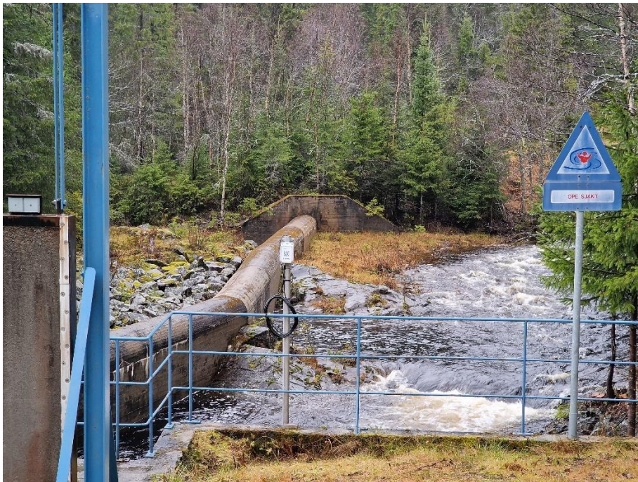
Figur 12 - Bilde fra Skagerak Kraft av Kvernassbekken med trykkmåler i vannet og en moderne datainnsamler.
