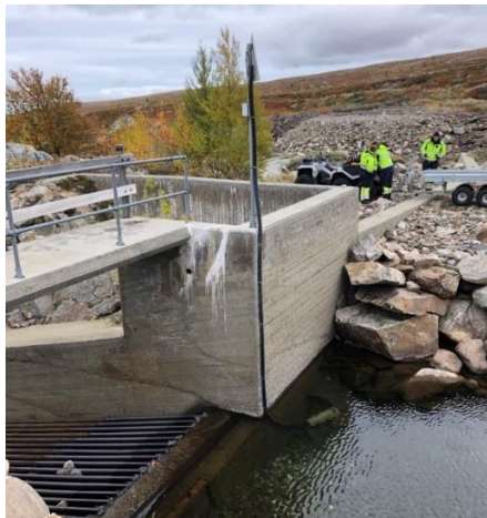
Figur 11 - Vannmåling av bekkeinntak med IoT-enhet montert på siden av informasjonsskilt. 14
