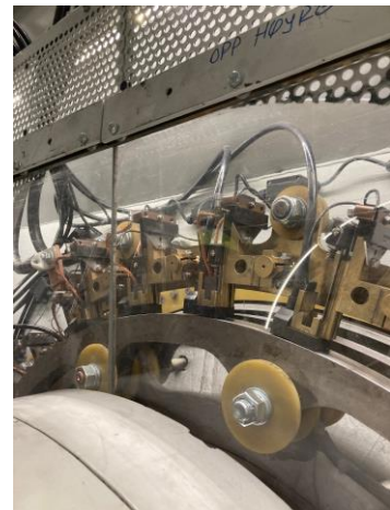
Figur 23: Mersen børster med sensorer (kilde: NTE)
