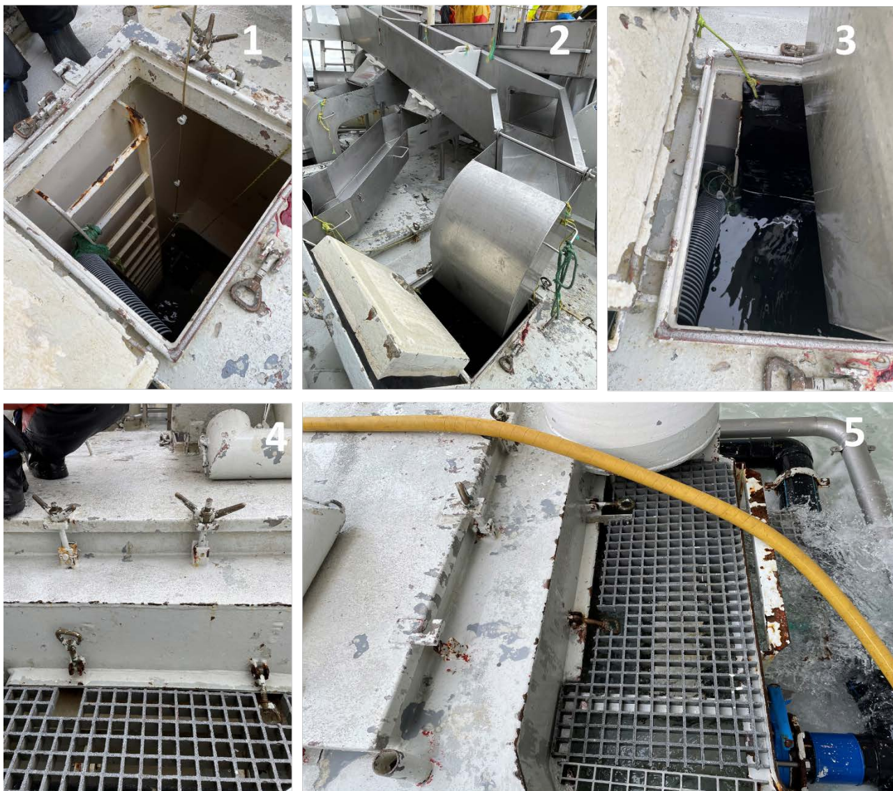
Figur 6. Levendelagringstank «styrbord akterut» som ble nyttet for målinger. (1) Ankomst til tank fra shelterdekk med monterte temperaturloggere fra bunn til topp av tanken langs lederen. (2) Renne fra sorteringsbord og ned i levendelagringstank (3) Plastdekke fisken møter i tank fra sorteringsrenne. (4-5) overrenningsrist på topp av levendelagringstank og ut på shelterdekk.
