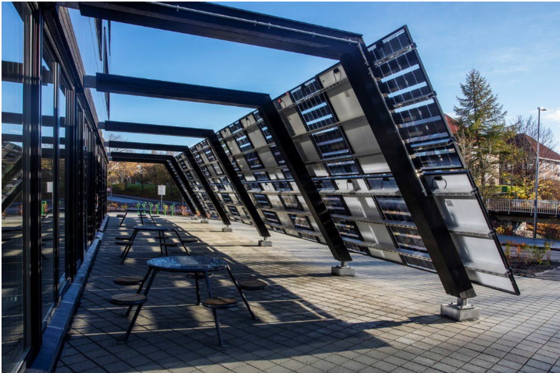
Figur 3.10: Pergolaen mot sør er forsøksfelt for solceller samtidig som den gir skygge som skjermar første etasje mot soloppvarming. Foto: Lindbak
