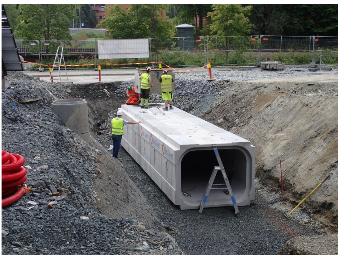
Figur 3.15: Installering av 52 m 3 fordrøyningstank for oppsamling av vatn frå dei ulike delane av overvannshandteringssystemet rundt ZEB-laboratoriet.
