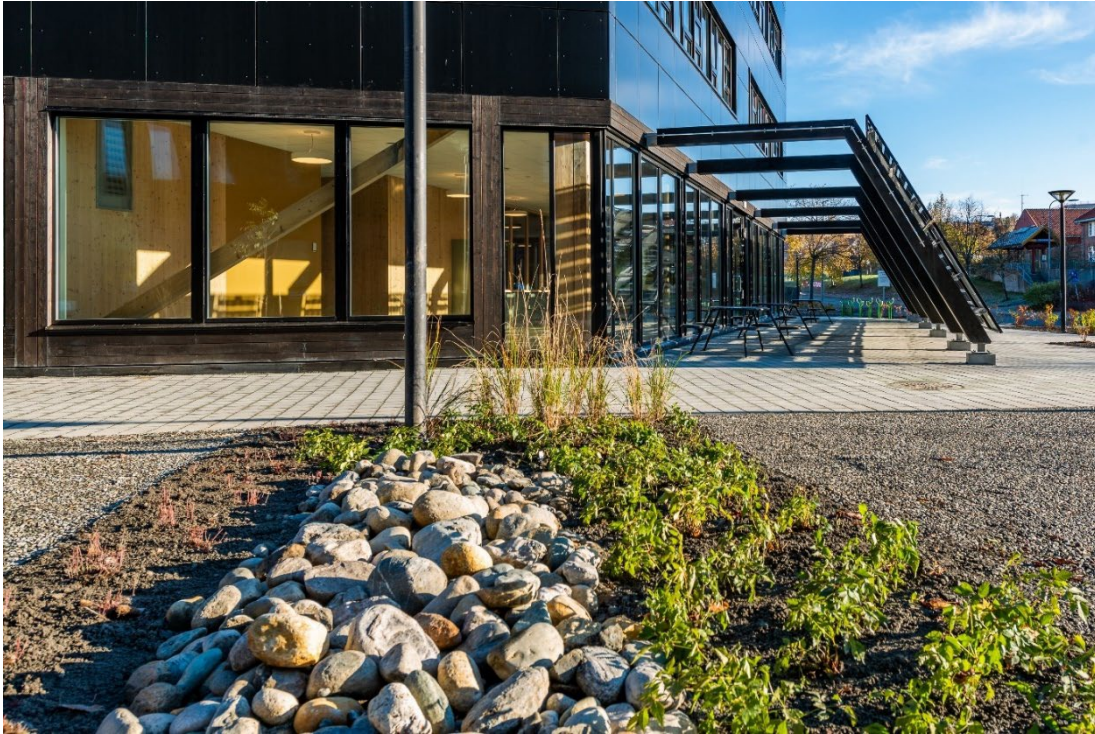
Figur 3.13: ZEB-laboratoriet på Gløshaugen i Trondheim er ein viktig forskingsinfrastruktur også for utvikling av nye overvannsløysningar. Foto: m.c.herzog / visualis-images.
