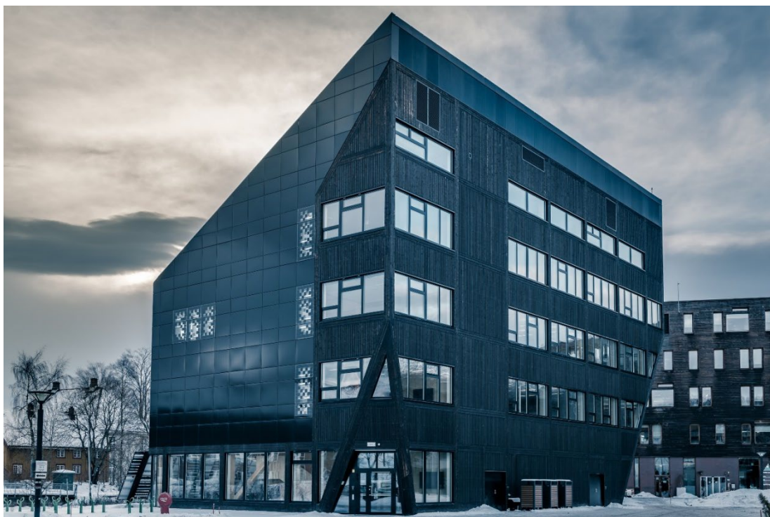
Figur 3.1: I utvikling av ZEB-laboratoriet har vi fokusert både på klimagassreducerande tiltak og på tiltak for klimatilpassing til eit framtidig klima. Inkludert er også eit anlegg for handtering av overvatn tilpassa dei lokale forholda. Foto: Nicola Lolli, SINTEF.
