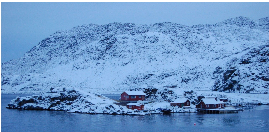
Figur 2.1: Eksempel på lokal klimatilpassing frå Nordkapp kommune. Bygningane er plassert i ly mellom to knausar ute på odden.
