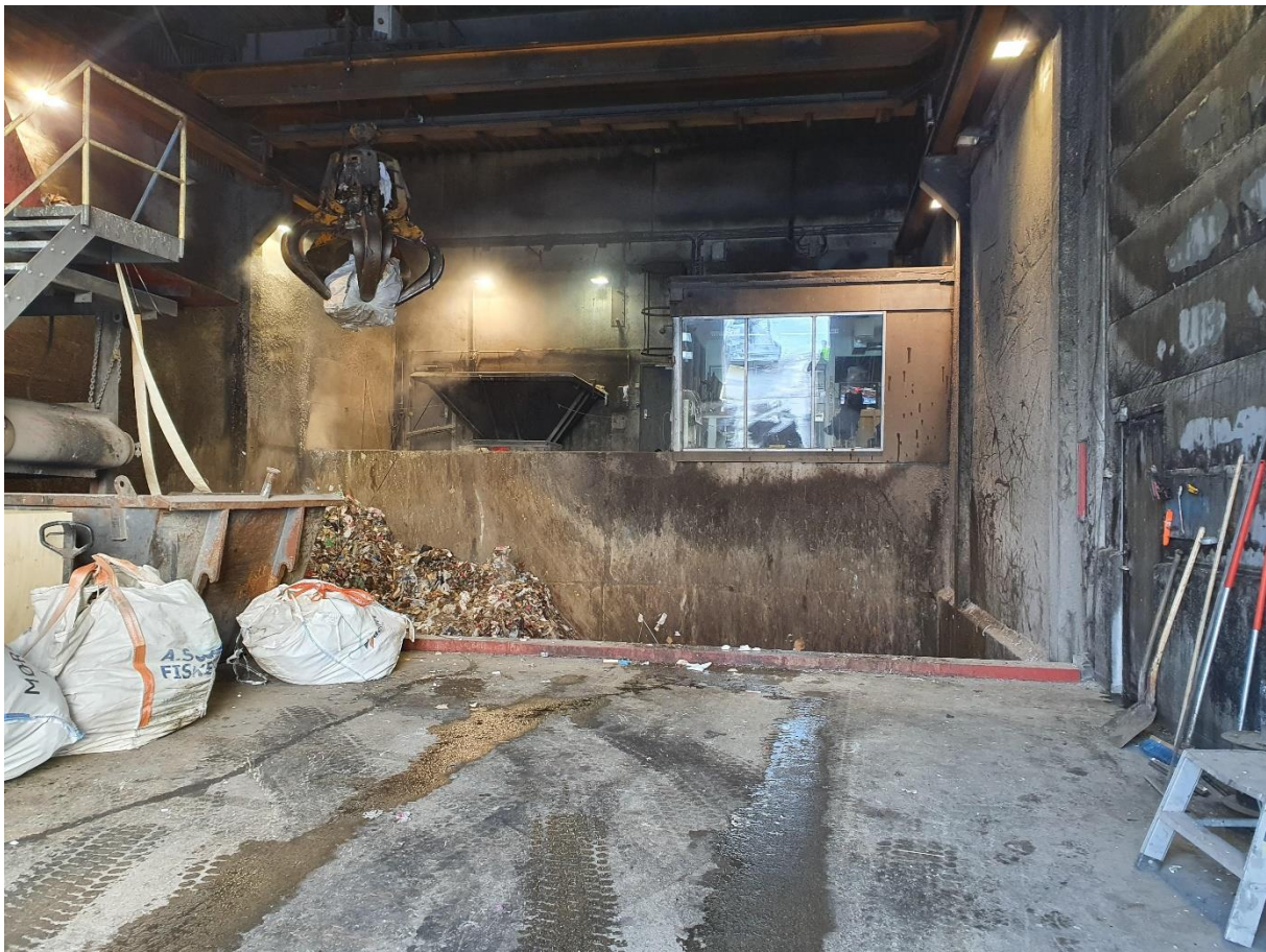
Figur 6 Kasserte linerredskap i storsekker løftes med kran ned i sjakten.
