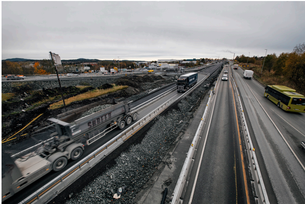
Tunge steinmasser flyttes ofte over store avstander til deponi eller pukkverk. Det medfører betydelige klimagassutslipp. Beregningsverktøyet SteinLCA kan synliggjøre og sammenlikne klimagassutslipp for ulike scenarier for håndtering av steinmasser i anleggsprosjekter. Foto: SINTEF
