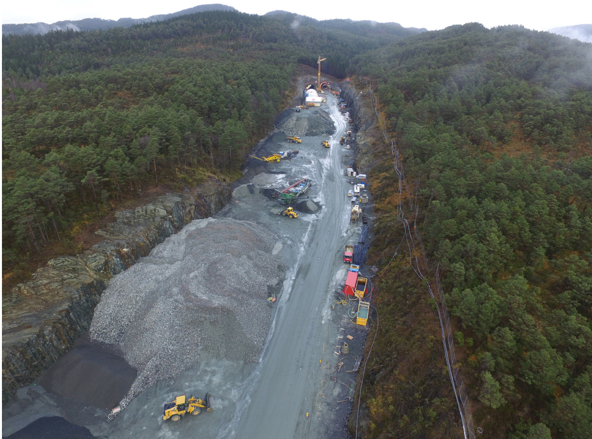
Deponi og mellomlagring for overskuddsmasser fra bygging av ny E39 Os-Bergen (Svegatjørn-Rådal). Her er det tillatt deponert inntil 1,2 millioner m 3 spengstein. Foto: Veidekke
