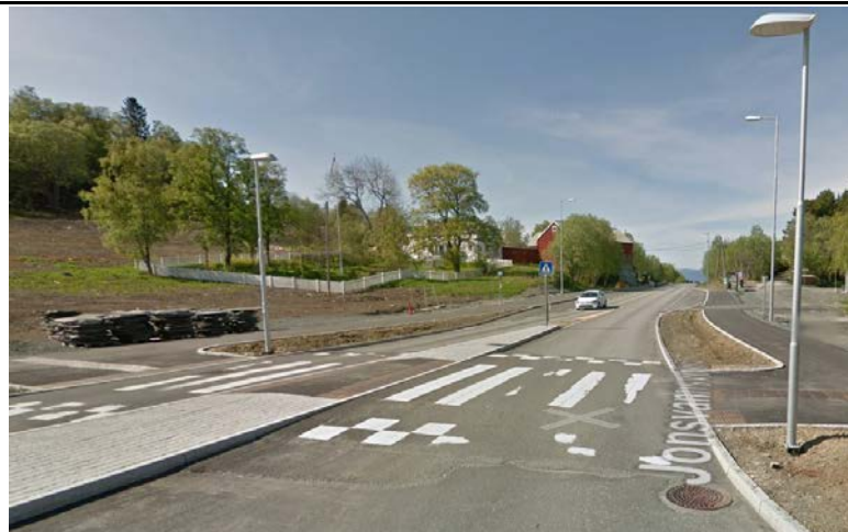
Opphevet gangfelt sett fra rundkjøringen
