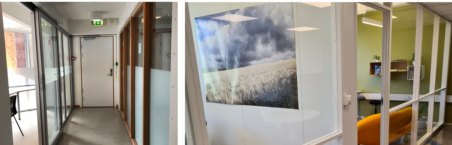
Eksempler på innvendige glassvegger. Foto: SINTEF Community
