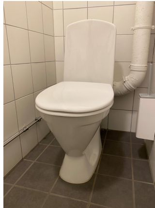
Eksempel på vegghengt klosett (P-lås) og gulvmontert klosett (S-lås) med sisterner. Foto: SINTEF Community
