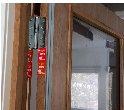
Lydisolerende egenskaper eller brannmotstand er ofte vist med et merke på dørkarmen eller på dørbladets kant. Foto: SINTEF Community
