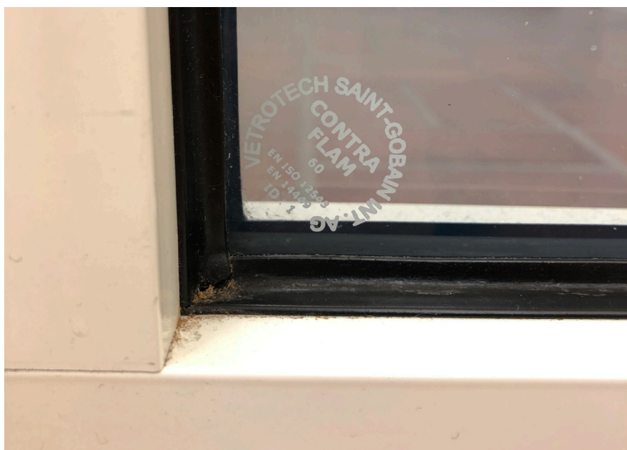
Eksempler på merking av innvendige glassvegger. Foto: SINTEF Community
