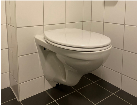
Eksempel på vegghengt klosett (P-lås) og gulvmontert klosett (S-lås) med sisterner. Foto: SINTEF Community
