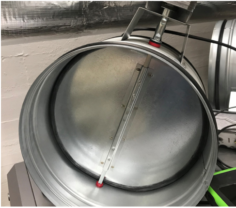
Eksempler på spjeld. Foto: SINTEF Community
