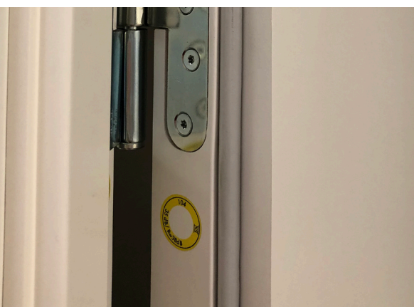
Lydisolerende egenskaper eller brannmotstand er ofte vist med et merke på dørkarmen eller på dørbladets kant. Foto: SINTEF Community
