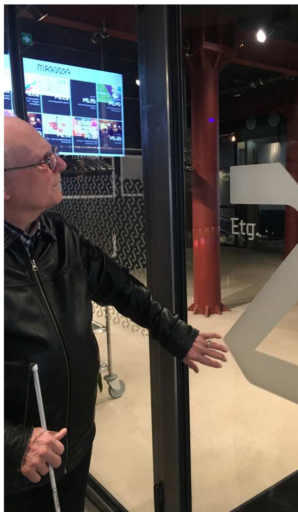
Glassfeltet har merking med ett bredt bånd istedenfor glassmarkør i to høyder, som spesifisert i TEK .
