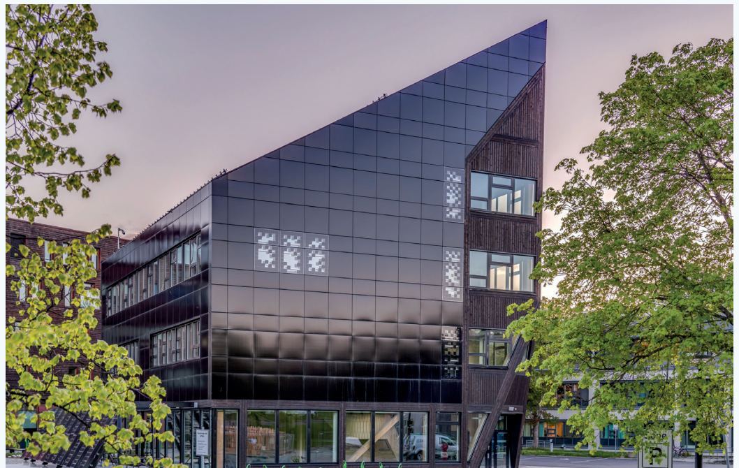
ZEB-laboratoriet på Gløshaugen i Trondheim har bygningsintegreerte solceller på alle flater med stor nok soltilgang. Her er utvikla nye løysningar, og erfaringar frå prosjektet er no samla i rapport SINTEF Fag 82.
